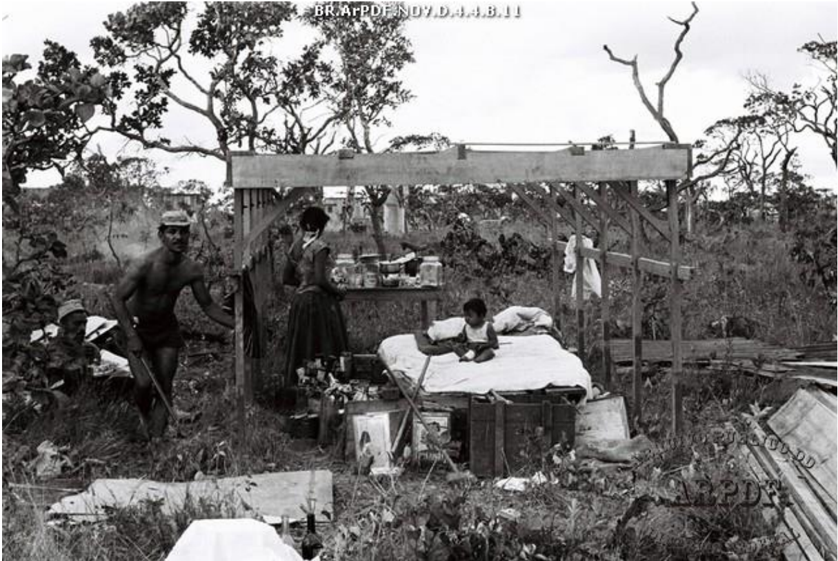
Figura 13: Barraco de candangos, em 1959. Autor: Mário Fontenelle.
