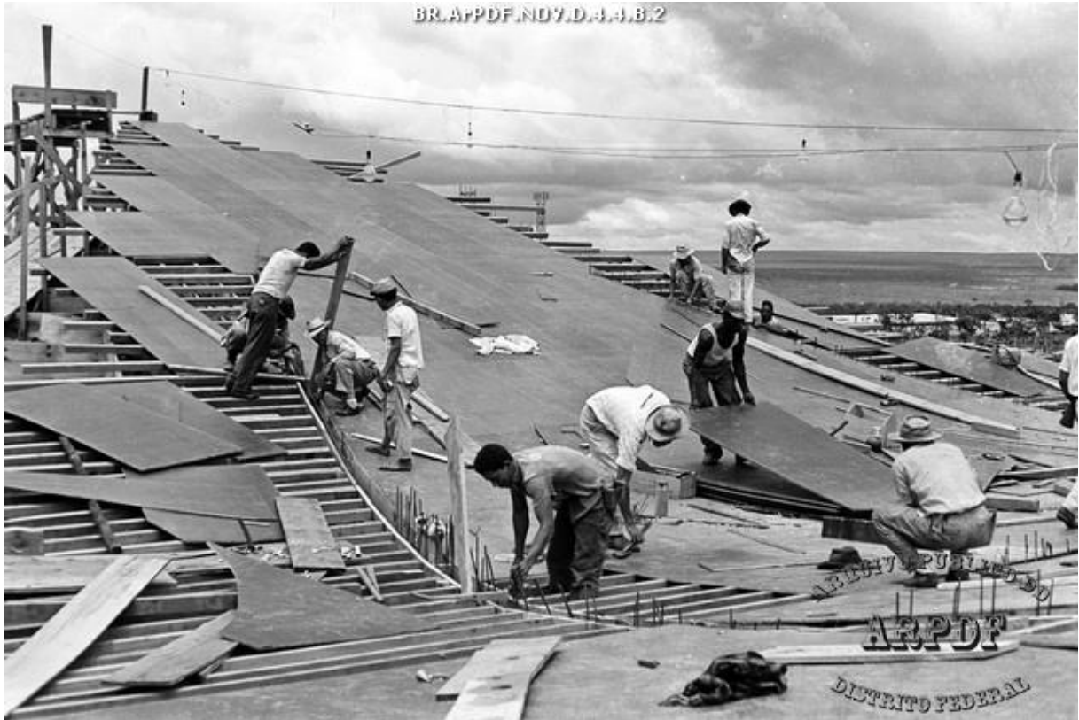
Figura 2: Operários na construção da Igreja Nossa Senhora de Fátima (Igrejinha), em 18/03/1958. Autor: Mário Fontenelle.
