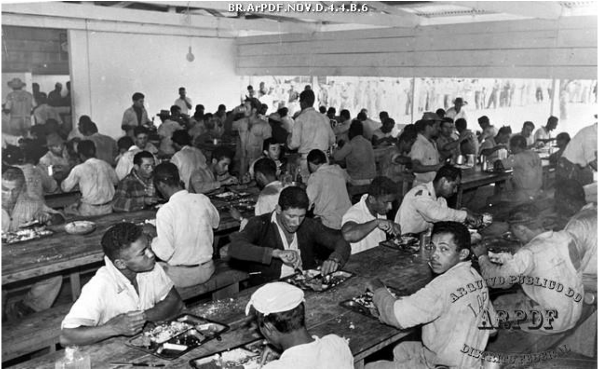
Figura 3: Refeitório do canteiro de obras do IAPB (Instituto de Aposentadoria e Pensões dos Bancários), em 24/05/1958. Autor: Mário Fontenelle.
