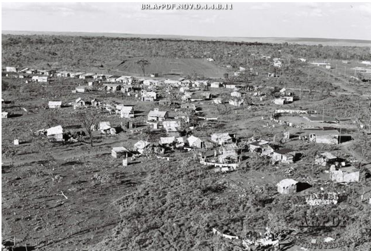
Figura 10: Moradias de madeira, em 30/09/1958. Autor: Mário Fontenelle.
