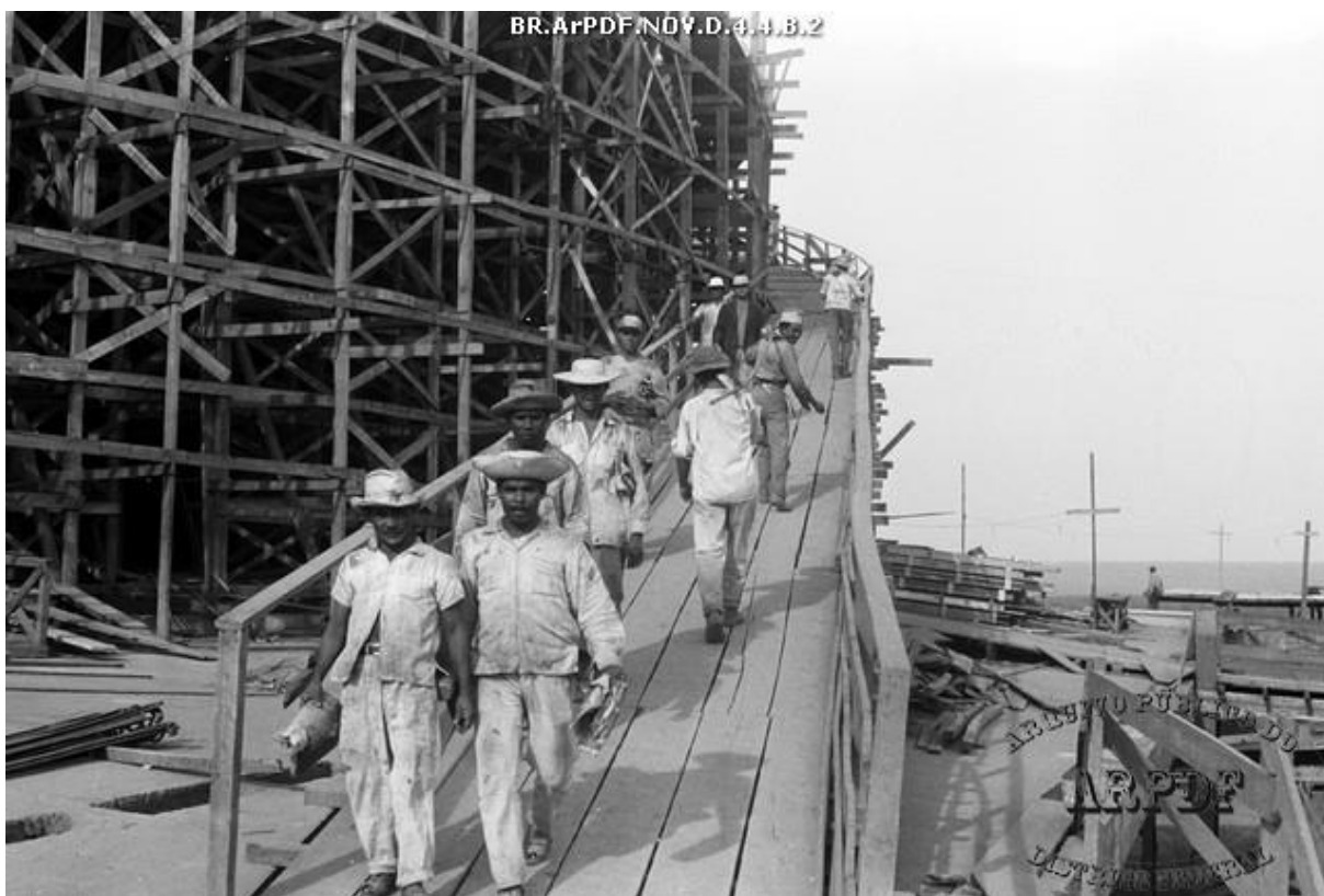
Figura 1: Operários na construção do Congresso Nacional, entre 1958 e 1960. Autor: Mário Fontenelle. 37
