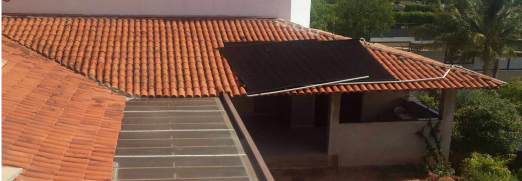
Figura 16 - Imagem do telhado disponível para implementação fotovoltaica
