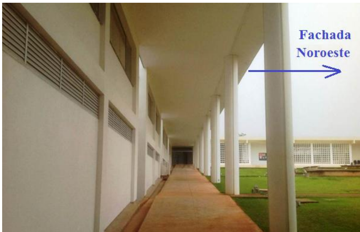
Fig. 1.5 – FACE, fachada interna noroeste
