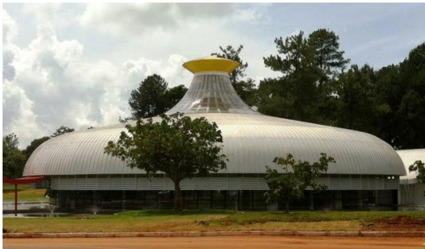
Fig. 2.21 – Beijódromo, UnB. Exemplo de uso de ventilação vertical (fonte:www.panoramio.com, acessado em 09/07/2014, 20,54h)
