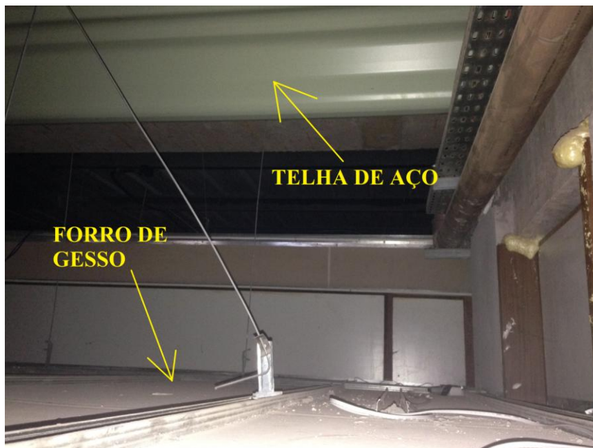
Fig. 3.3 – Espaço entre telha e forro no bloco D
