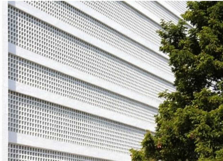
Fig. 2.5 – Exemplo de fachada com cobogós (SQS 107, bloco A, Brasília, 2014)
