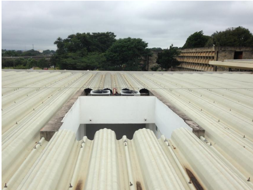
Fig. 3.2 – Cobertura do bloco D da FACE
