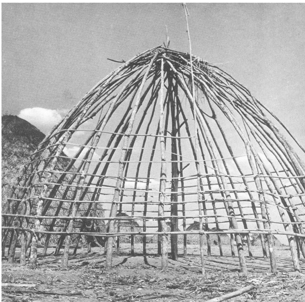
Figura 22 – União confusa dos galhos no ápice da edificação (GIACCARIA e HEIDE, 1984, p. XX)
