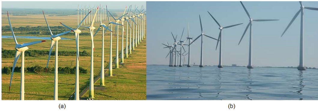
Figura 2.10: Parque eólico on-shore (a) e off-shore (b)
