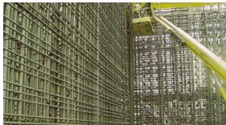
Figura 2 – Parede de simulação de terremotos. Fonte: Grace (2005)
