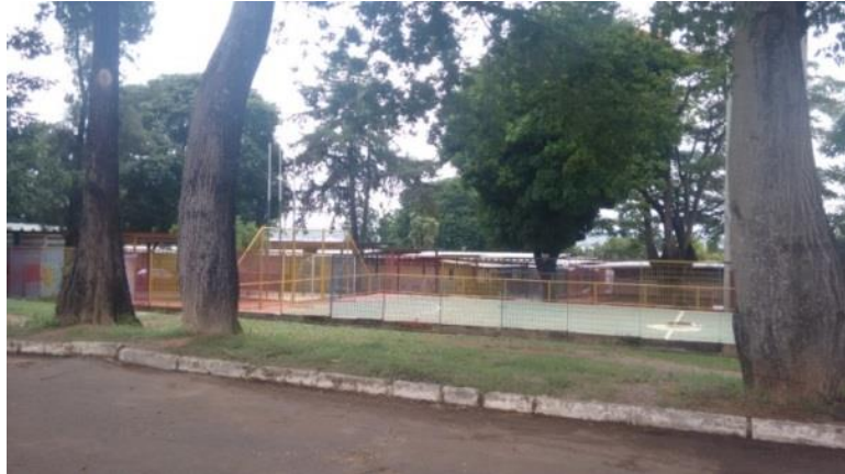
Figura 12: Fachada da escola
