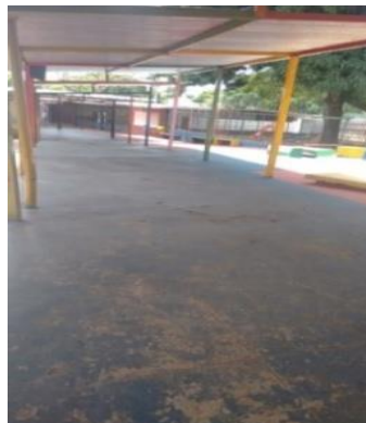
Figura 13: Interior da escola, entrada.
