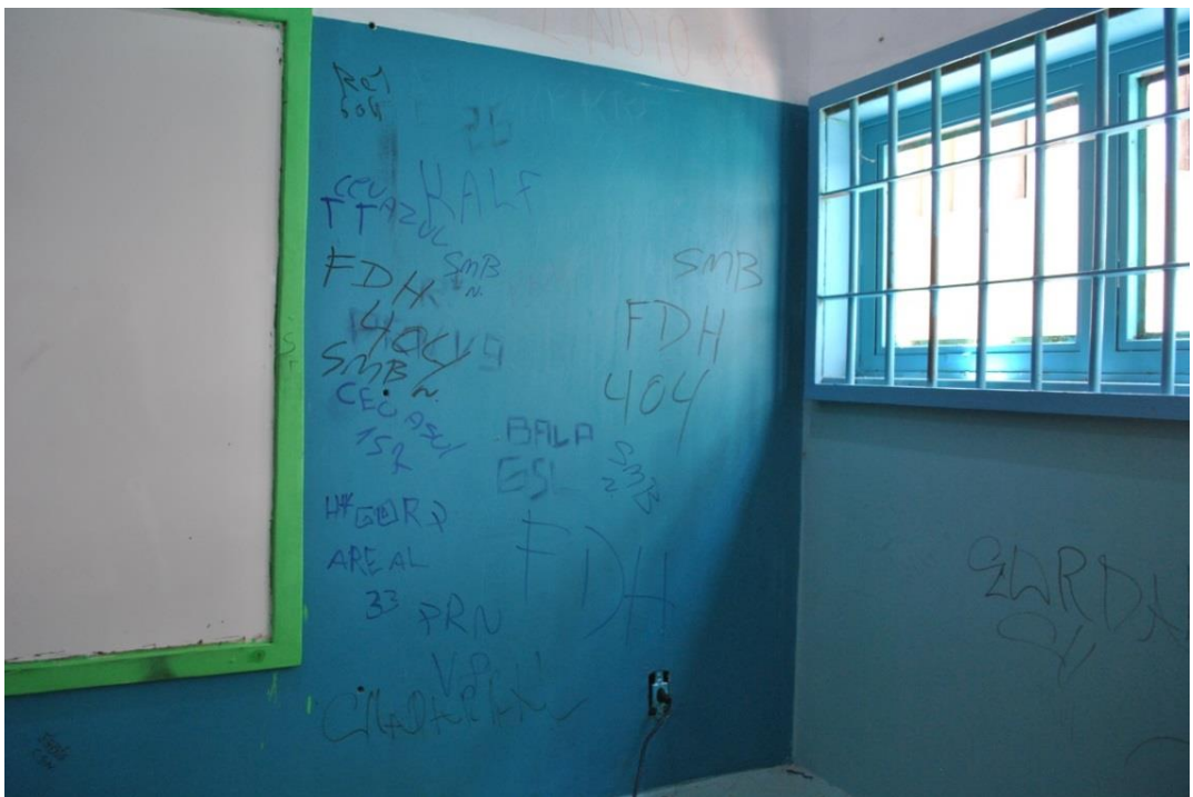
Uma das salas de aula do corredor que atendi, com cerca de 10m 2 . Não há muito conforto e iluminação. Grades estão presentes nas janelas e na porta, semelhantes às celas.
