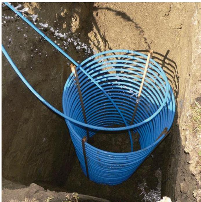
**Figura 2.7 - Aplicação de estaca na fundação (Fonte: Pompe à chaleur géothermique)**
