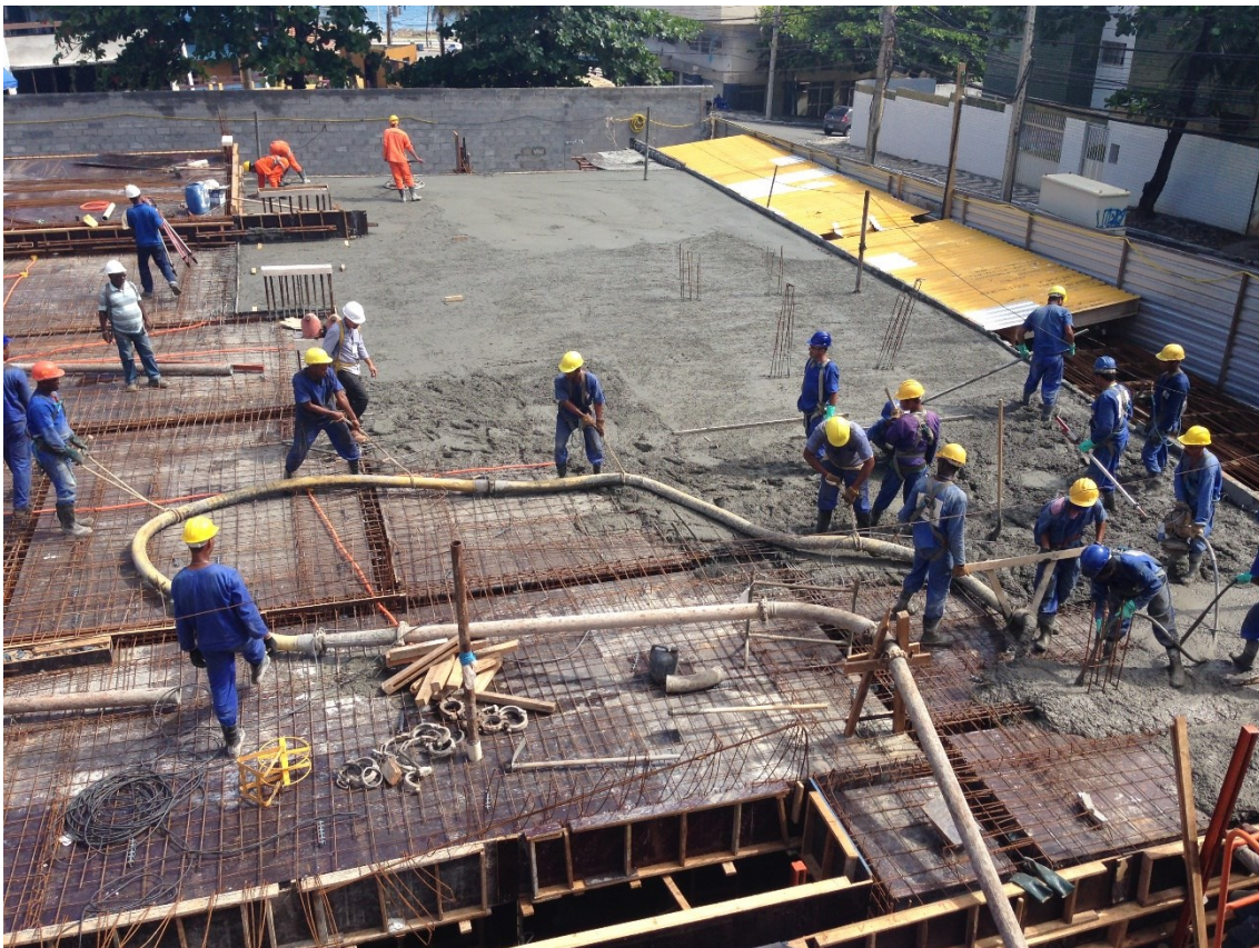
Figura 1: Concretagem in loco de laje.
