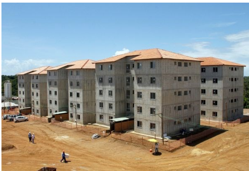
Figura 11: Conjunto residencial do programa Minha Casa Minha Vida construído com paredes de concreto em São Luís (MA).
