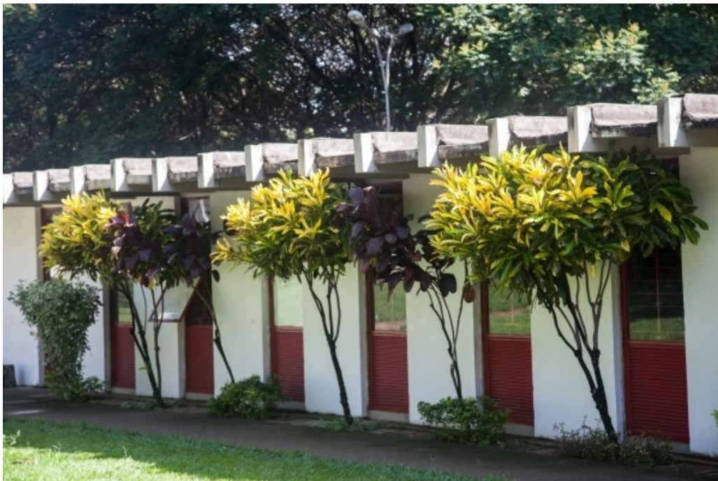
Figura 3: Edificação do CEPLAN na UnB, construído com método de pré-moldagem.
