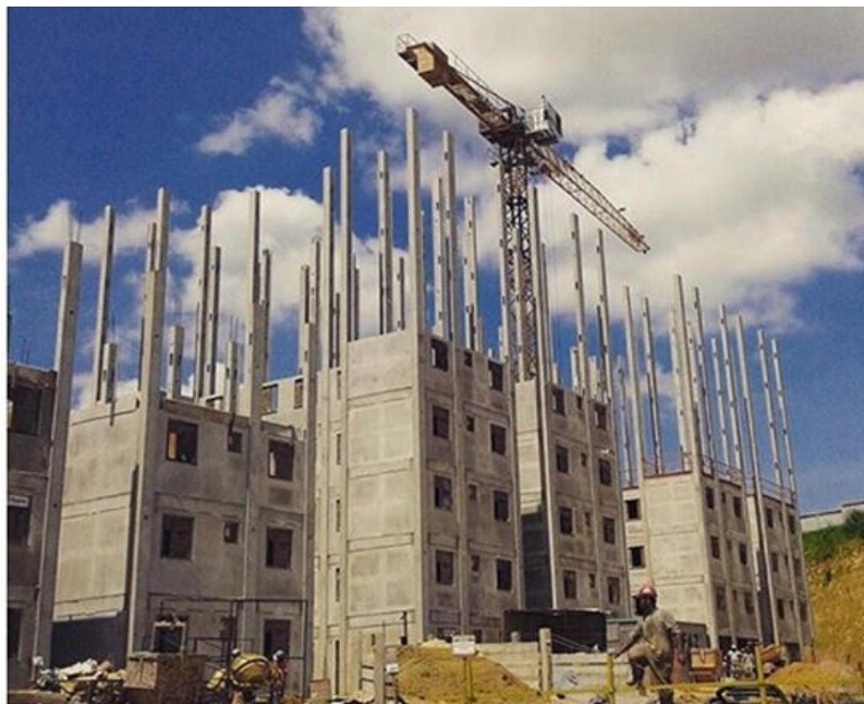
Figura 13: Edificação residencial popular do programa Minha Casa Minha Vida feita com elementos pré-fabricados.
