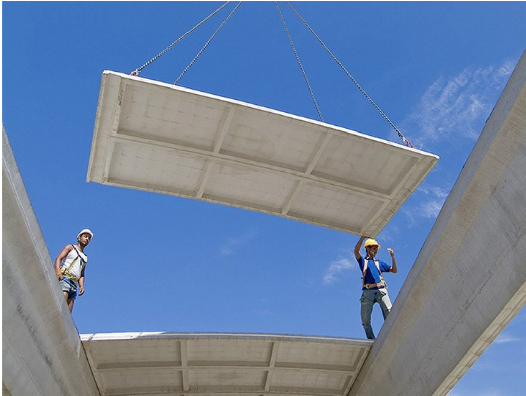
Figura 2: Instalação de laje de concreto pré-fabricada.
