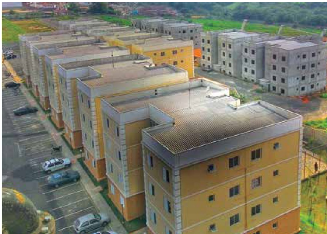
Figura 15: Residencial Monterrey, habitação social do programa MCMV em São Paulo.
