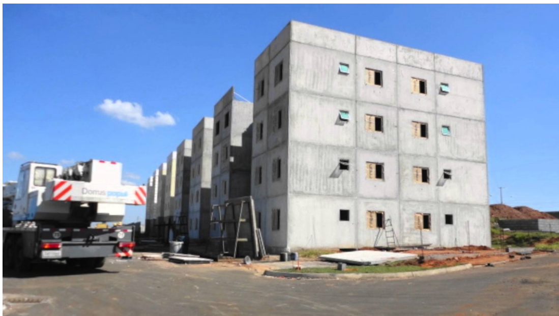
Figura 14: Construção do Residencial Monterrey feito com elementos pré-fabricados.
