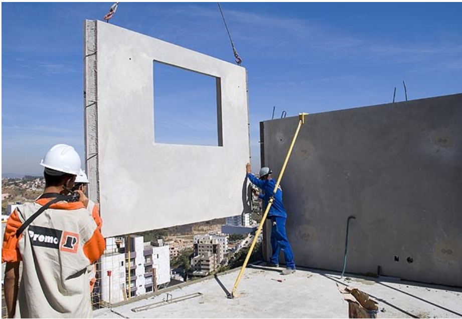
Figura 12: Instalação de parede de concreto armado em residência do programa MCMV.
