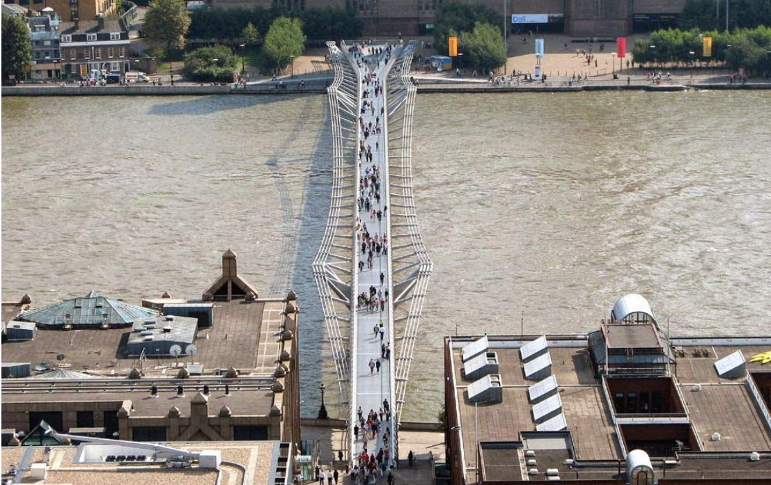
Figura 12 - Vista superior da Passarela do Milênio
