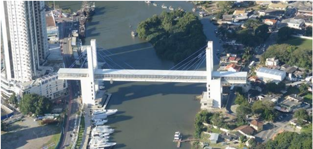
Figura 14 - Passarela da Barra em Santa Catarina
