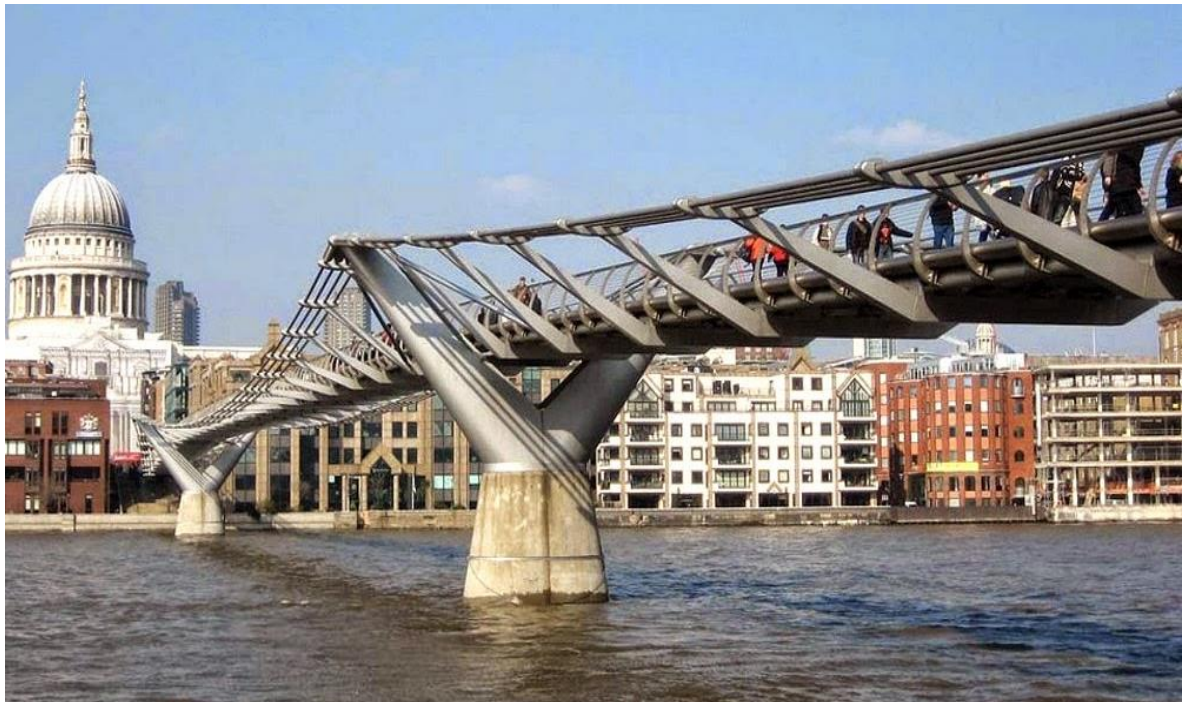
Figura 11 - Passarela do Milênio na Inglaterra
