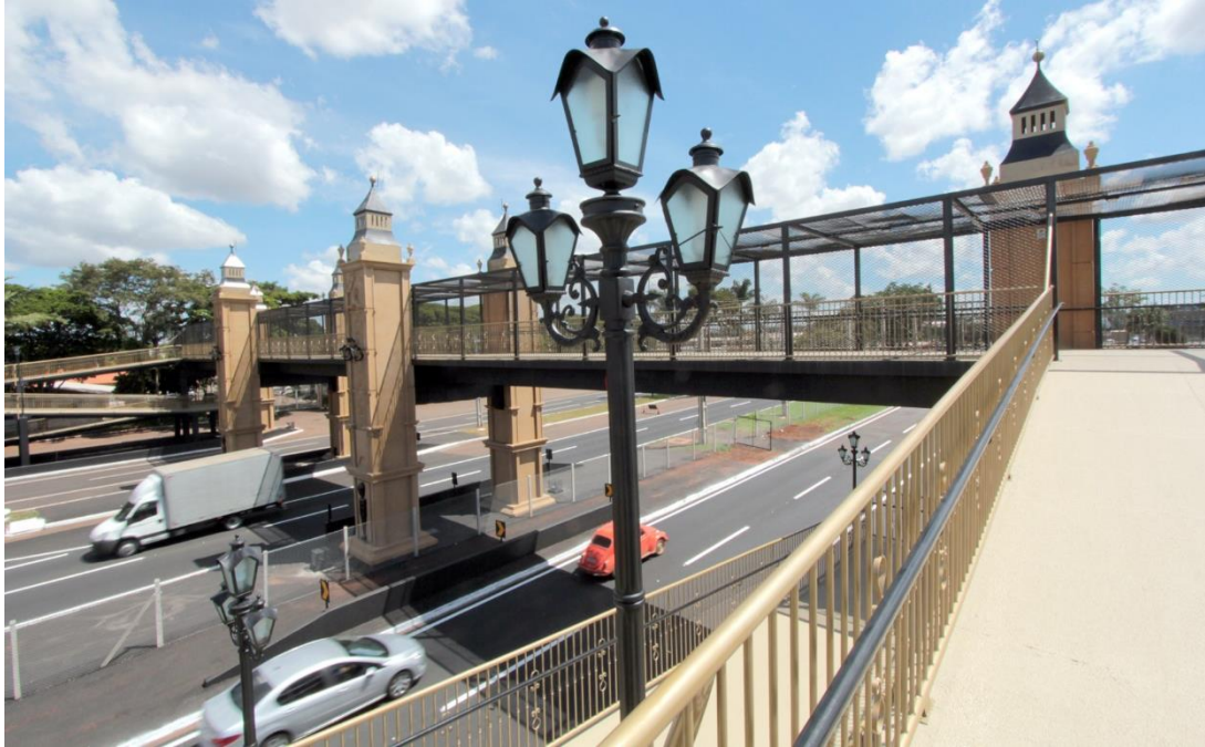
Figura 9 - Passarela em viga Virendel na BR 369 no Paraná
