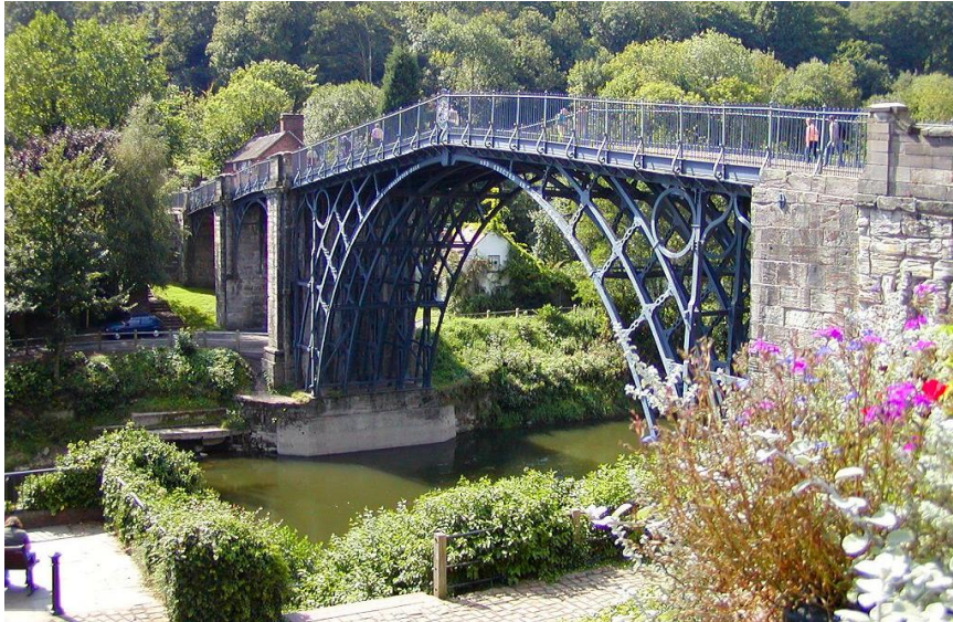
Figura 1 - Ponte Coalbrookdale, Inglaterra.
