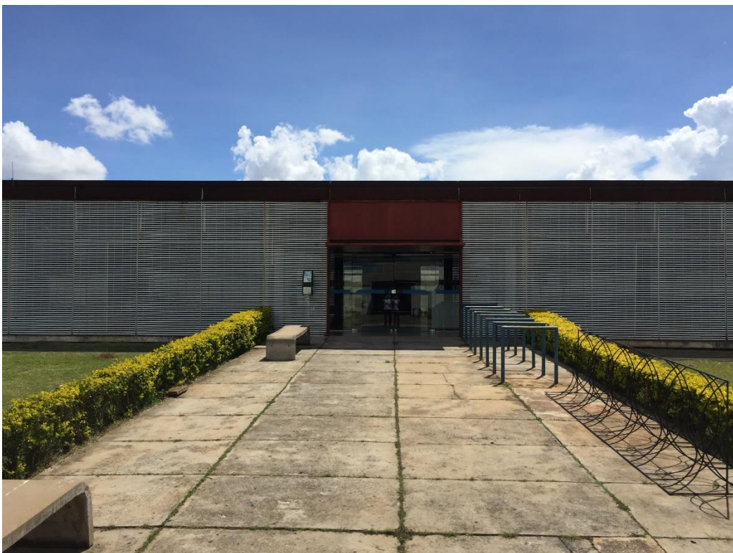
Figura 8 – Fachada Lateral do PJC, nota-se a presença de um brise metálico. FONTE: autor.
