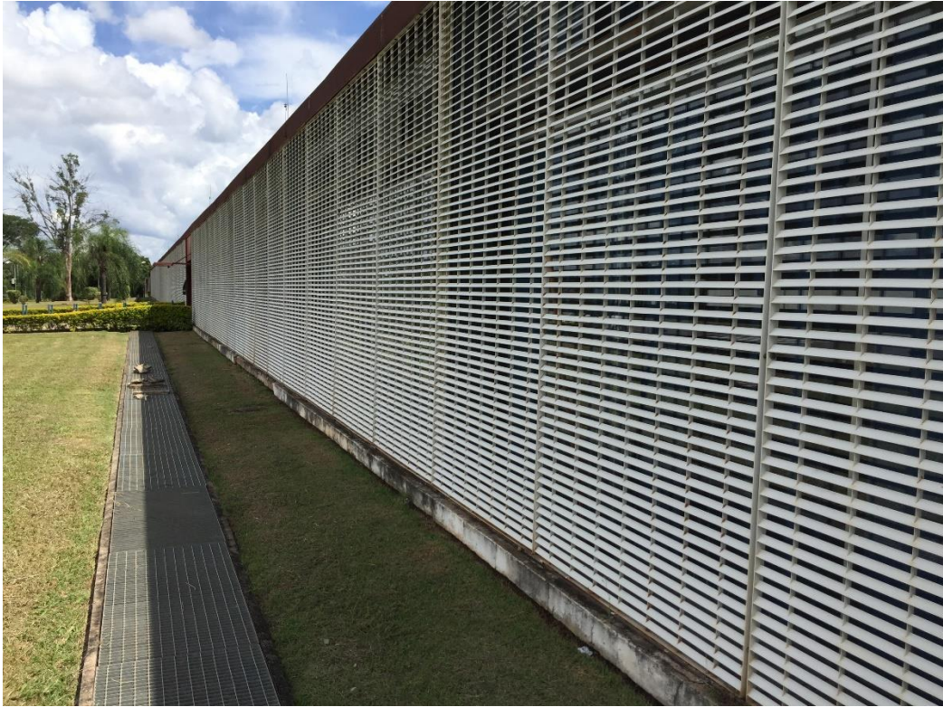
Figura 8 – Fachada Lateral do PJC, nota-se a presença de um brise metálico. FONTE: autor.
