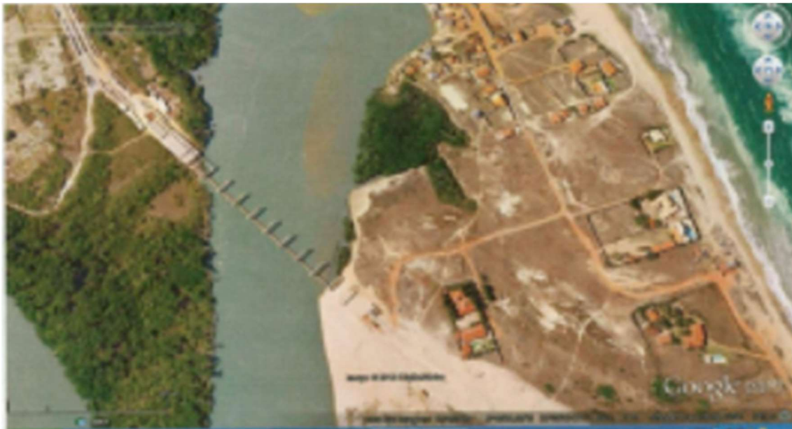
Figura 12: Imagem da obra de arte especial da Travessia do Rio Cocó, ligação da Praia do Futuro com a Praia da Sabiaguaba, Ceará (2009). Fonte: TC 020.318/2009-2.
