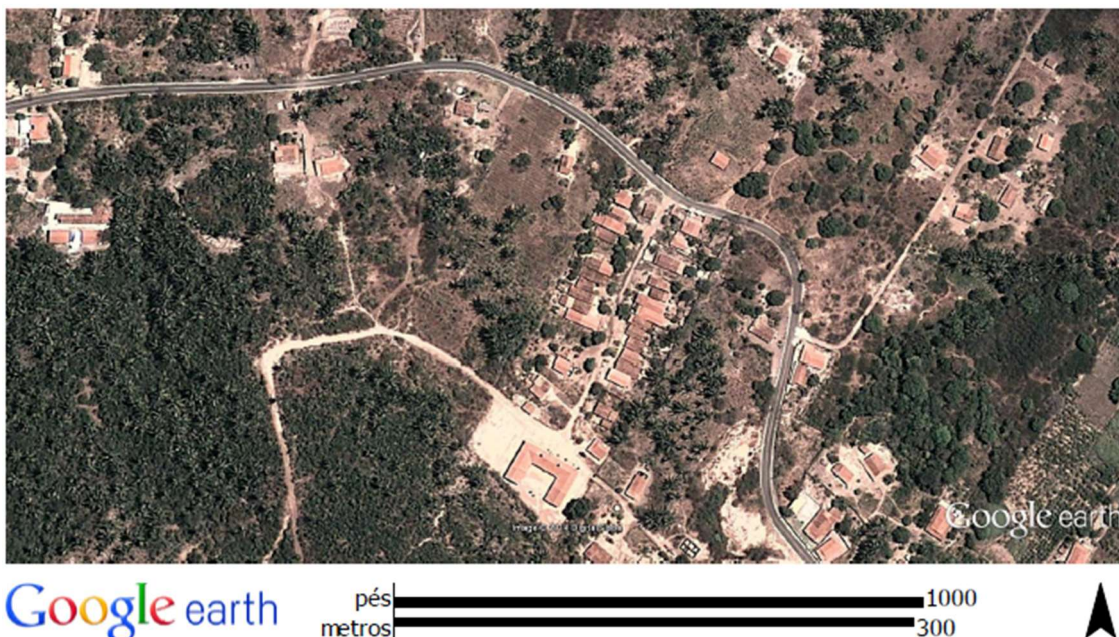
Figura 11: Foto constante da peça 10 do processo 028.278/2012-7 onde mostra a execução de pavimentação asfáltica.
