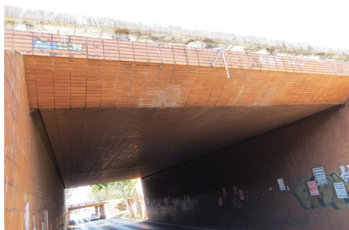
Figura 4.8 – Visão geral do viaduto Eixão
