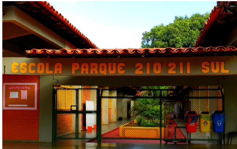
Figura 2. Escola Parque da 210/211 sul.
