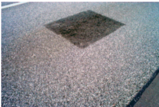
Figura 2.10 – Remendo bem executado
