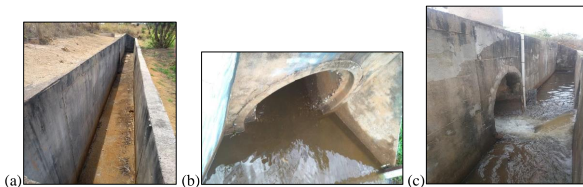
Figura 4.16 – a) vertedor da lagoa de detenção; b) entrada da descarga de fundo; c) águas pluviais escoando pela descarga de fundo do vertedor.
