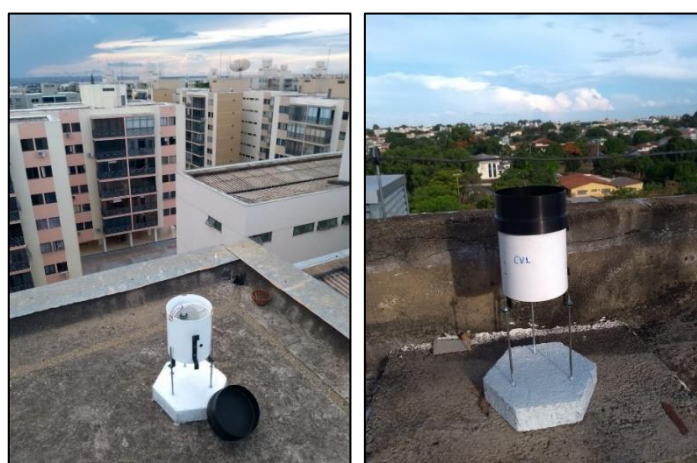
Figura 4.11 – Pluviógrafos instalados em telhados de prédios.
