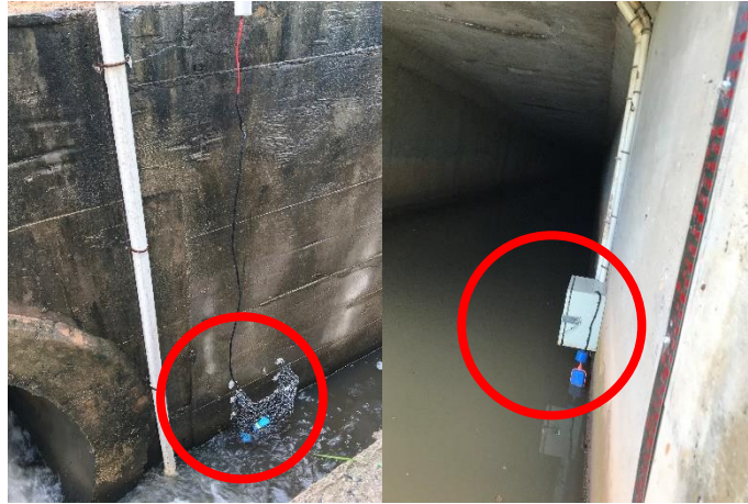
Figura 4.14 – Boias de ativação do amostrador automático no vertedor (esquerda) e galeria de drenagem na entrada da lagoa (direita).
