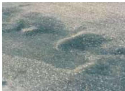
Figura A.17 – representação de corrugação (SHRP, 2003)
