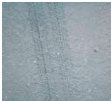
Figura A.18 – representação de exsudação (SHRP, 2003)
