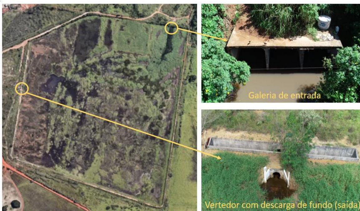
Figura 4.4. Lagoa de retenção do Guará com estruturas de entrada e saída.
