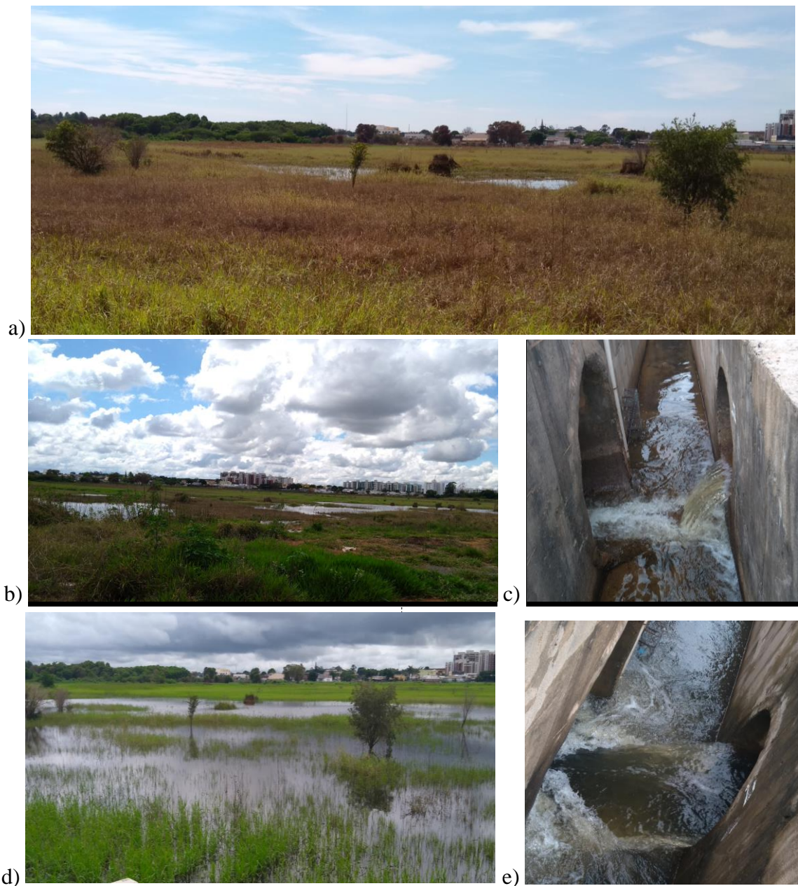
Figura 4.6. a) área dentro da lagoa de retenção na primeira visita; b) área dentro da lagoa na segunda visita; c) Orifício de saída na segunda visita; d) área dentro da lagoa no dia 16/11/2018; e) Orifício de saída no dia 16/11/2018.
