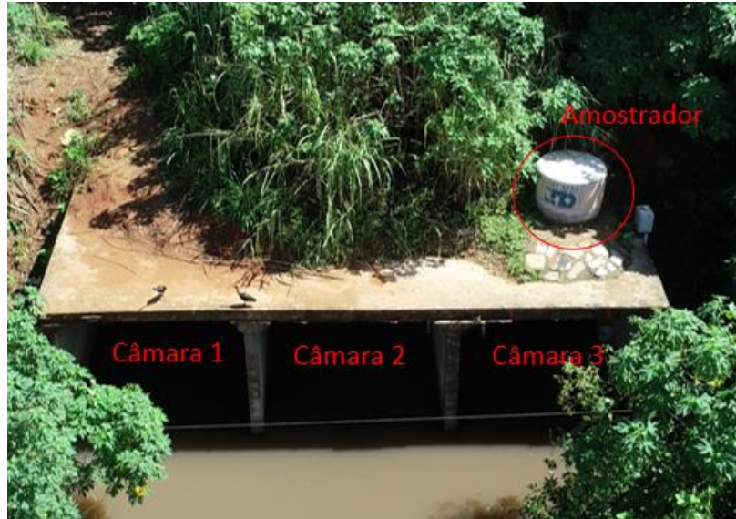
Figura 4.18. Entrada da lagoa de detenção, identificando as câmaras da galeria e o amostrador.
