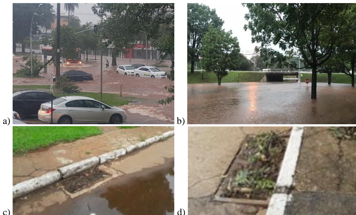
Figura 3.7. Deficiências na drenagem urbana no Distrito Federal: a) Alagamento na via W3 norte em outubro de 2018; b) Tesourinha na 109 norte alagada em abril de 2019; c e d) Bocas de lobo com grelhas entupidas.
