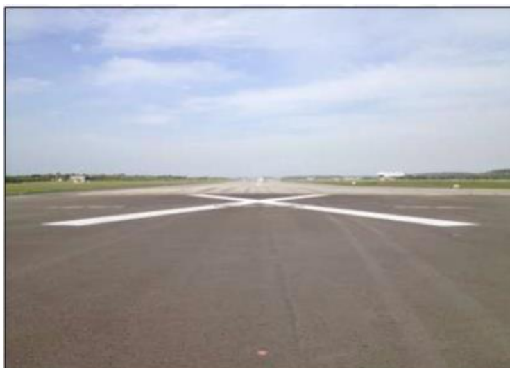
Figura 31: Sinalização da interdição da pista no sentido R10/28. Fonte: CENIPA.
