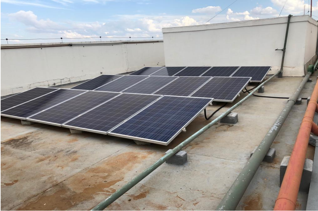
Figura 14 - Foto cobertura do MME 1, Fonte: própria
