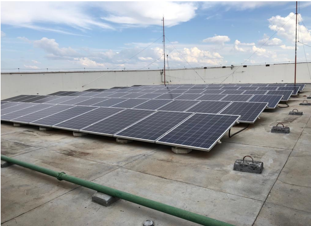
Figura 15 - Foto cobertura do MME 2, Fonte: própria
