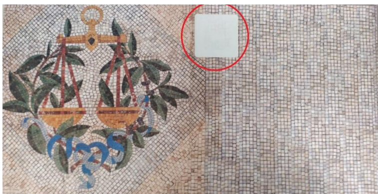
Figura 11: Localização superior da etiqueta RFID.
