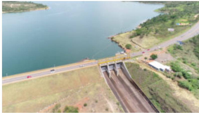
Figura 2.2 - Barragem do Paranoá (Disponível em https://minhacapital.com.br/laudo-da-ceb-indica-que-estrutura-da-barragem-do-paranoa-e-segura/barragem-lago-paranoa-romper-003/ .
