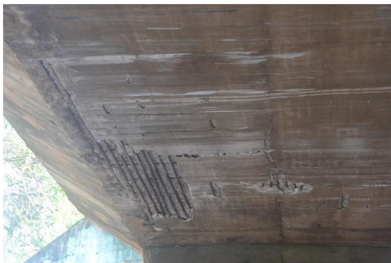
Figura 5.17: Elemento tabuleiro – Viaduto W – Quadra 11/12
