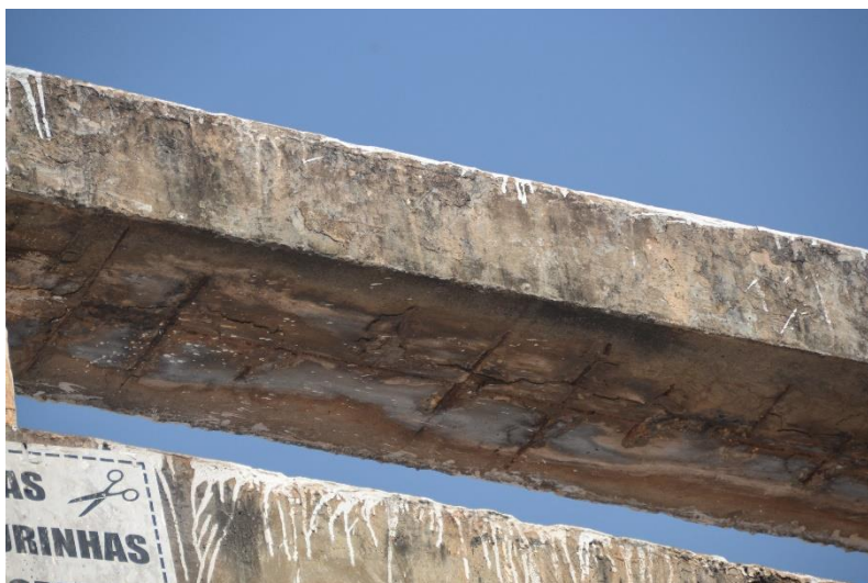
Figura 5.9: Elemento guarda-rodas L – Viaduto Central – Quadra 05/06
