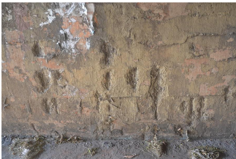
Figura 5.5: Elemento cortina central sul– Viaduto W – Quadra 03/04
