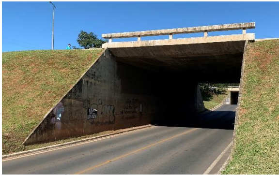
Figura 3.11: Viaduto Central - 09/10 Norte
