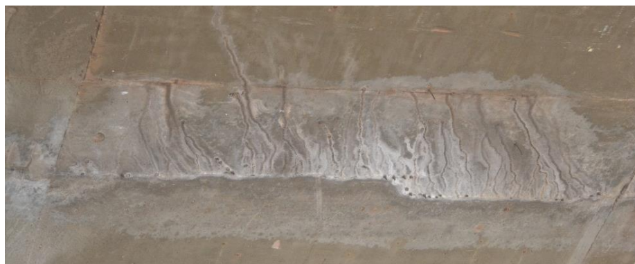
Figura 5.24: Elemento tabuleiro – Viaduto Central – Quadra 13/14 norte
