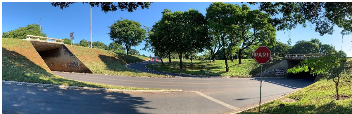
Figura 3.1: Visão panorâmica dos Viadutos Central e L na entrequadra 05/06 Norte
