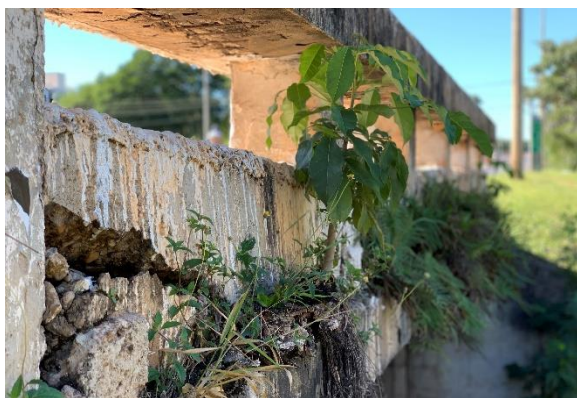
Figura 3.9: Viaduto Central - 11/12 Norte
