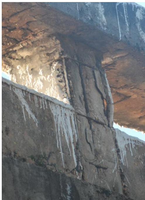
Figura 30: Exemplo B - deslocamento com fator de intensidade 3
