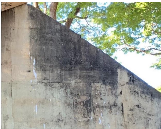
Figura 4.1: Exemplo de manchas na superfície - cortina lateral – 05/06 Norte, Brasília – DF.
