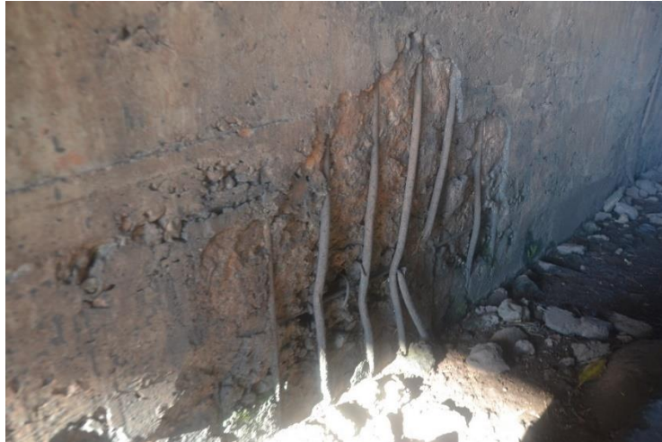
Figura 5.26: Elemento cortina central sul – Viaduto L – Quadra 13/14
