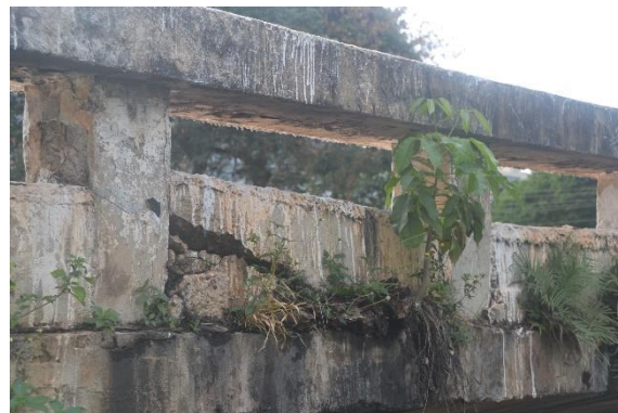
Figura 5.19: Elemento guarda-rodas W – Viaduto Central – Quadra 11/12
