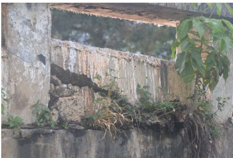
Figura 32: Exemplo B - deslocamento com fator de intensidade 4
