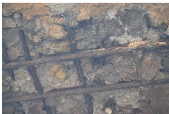
Figura 5.6: Elemento tabuleiro – Viaduto Central – Quadra 03/04
