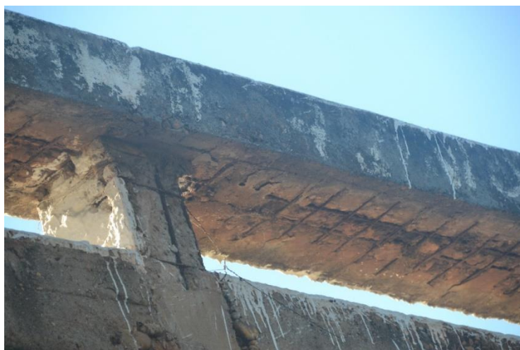
Figura 5.27: Elemento guarda-rodas W – Viaduto L – Quadra 13/14
