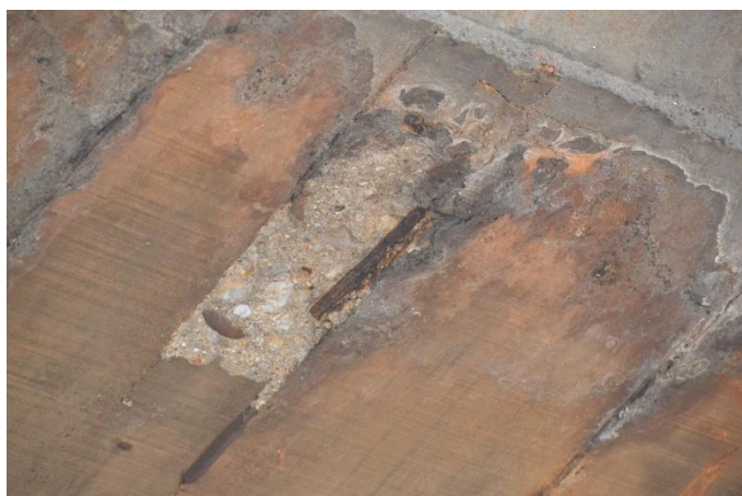
Figura 5.8: Elemento tabuleiro – Viaduto W – Quadra 05/06
