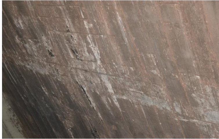
Figura 5.21: Elemento cortina central norte – Viaduto L – Quadra 11/12
