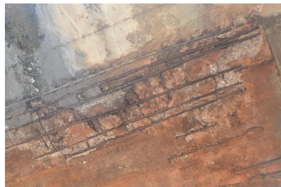
Figura 5.20: Elemento tabuleiro – Viaduto Central – Quadra 11/12
