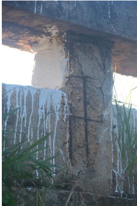
Figura 12: Exemplo A - cobrimento deficiente com fator de intensidade 3
