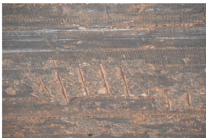
Figura 11: Exemplo C - cobertura deficiente com fator de intensidade 2
