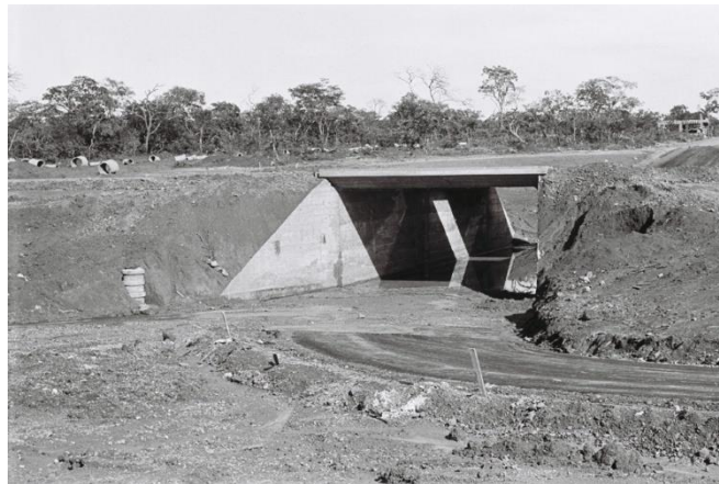
Figura 3.5: Viaduto central parcialmente concluído (ARQUIVO PÚBLICO DE BRASÍLIA)
