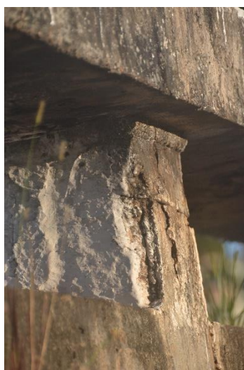
Figura 5.23: Elemento guarda-rodas L – Viaduto W – Quadra 13/14
