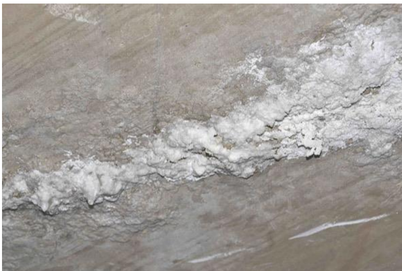
Figura 40: Exemplo B – eflorescência com fator de intensidade 4 (Fonte: www.ecivilnet.com )
