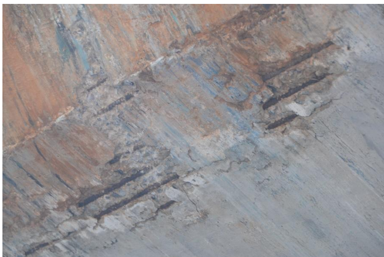
Figura 5.1: Elemento tabuleiro – Viaduto W – Quadra 01/02
