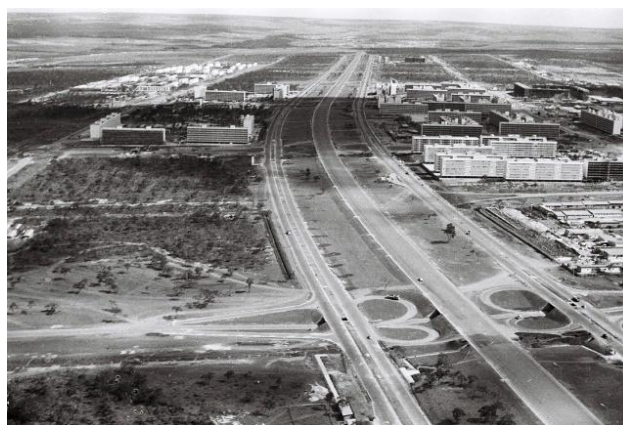
Figura 3.3: Imagem aérea do Eixo Rodoviário de Brasília – DF (ARQUIVO PÚBLICO DE BRASÍLIA)
