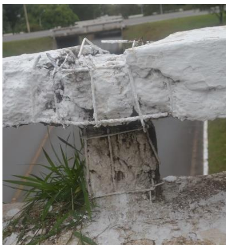
Figura 5.14: Elemento guarda-rodas L – Viaduto W – Quadra 09/10
