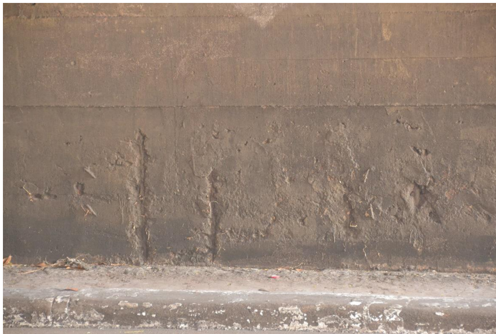
Figura 5.10: Elemento cortina central norte – Viaduto L – Quadra 05/06
