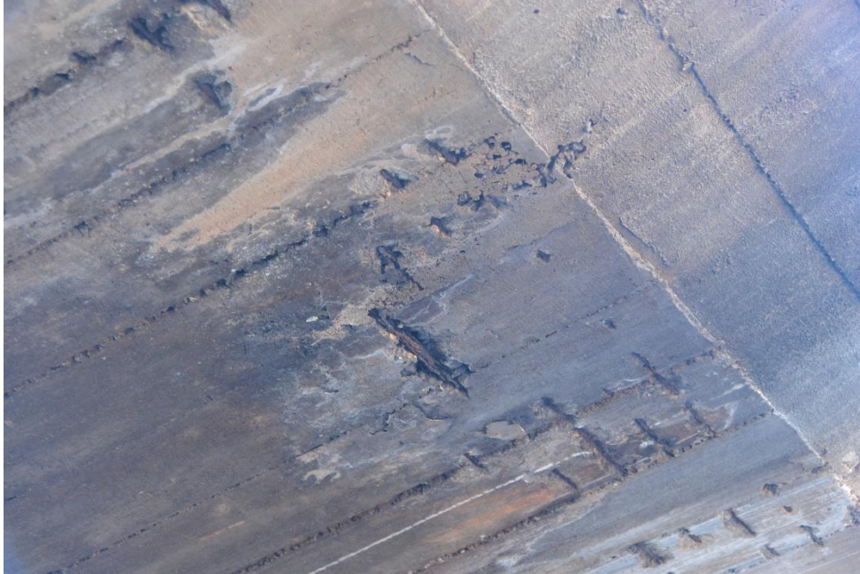
Figura 5.30: Elemento tabuleiro – Viaduto L – Quadra 15/16
