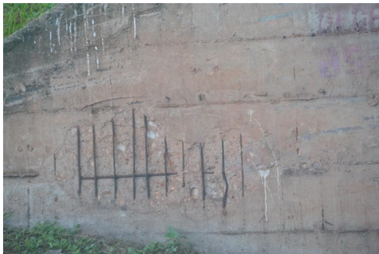
Figura 5.25: Elemento cortina norte W – Viaduto L – Quadra 13/14
