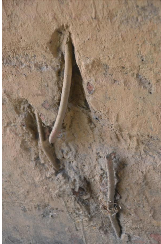
Figura 5.13: Elemento cortina central norte – Viaduto L – Quadra 07/08
