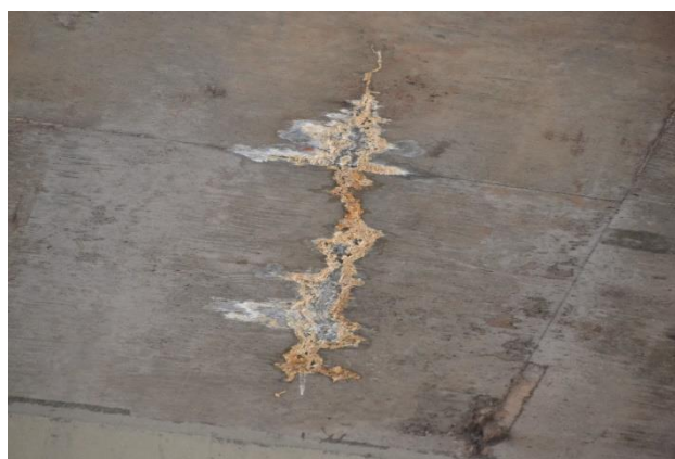
Figura 5.3: Elemento tabuleiro – Viaduto Central – Quadra 01/02
