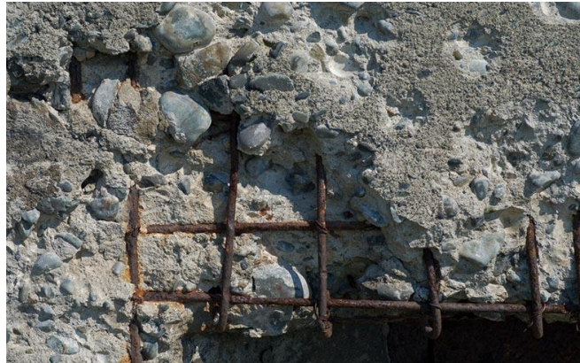
Figura 26: Exemplo A - desagregação com fator de intensidade 4 (Fonte: www.mapadaobra.com.br )
