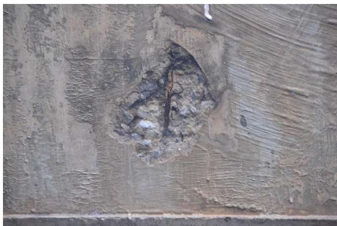
Figura 5.29: Elemento tabuleiro – Viaduto Central – Quadra 15/16
