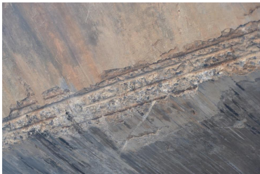
Figura 49: Exemplo B – abrasão do concreto com fator de intensidade 4
