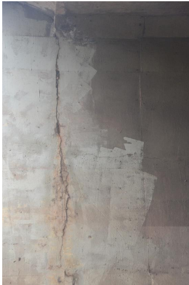
Figura 5.15: Elemento cortina central sul – Viaduto Central – Quadra 09/10
