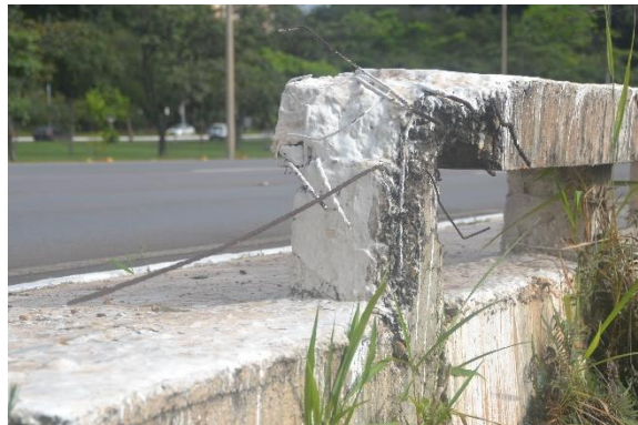
Figura 5.18: Elemento guarda-rodas L – Viaduto Central – Quadra 11/12
