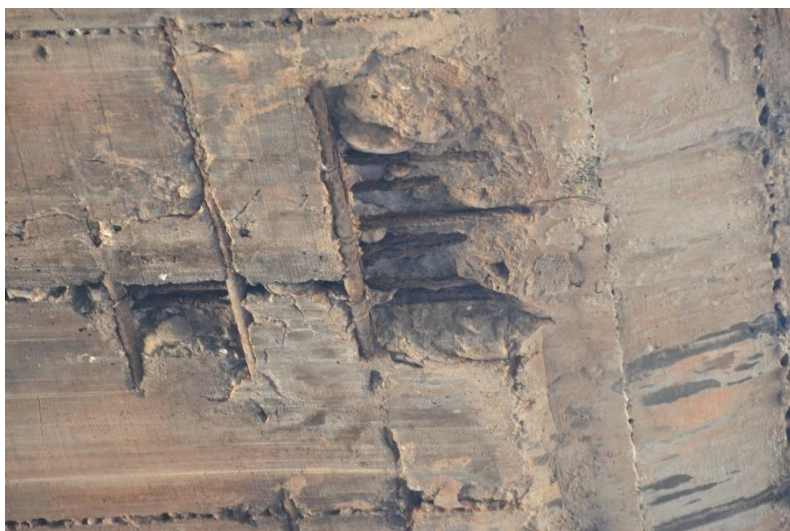
Figura 5.28: Elemento tabuleiro – Viaduto W – Quadra 15/16
