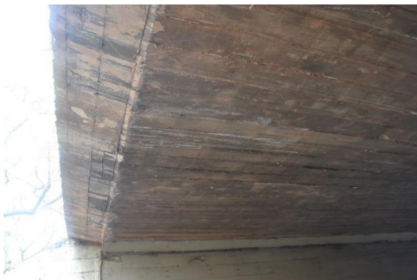
Figura 46: Exemplo A – abrasão do concreto com fator de intensidade 3
