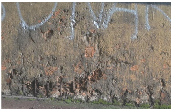
Figura 5.16: Elemento cortina central sul - Viaduto L – Quadra 09/10
