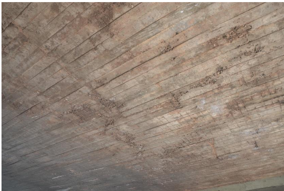
Figura 24: Exemplo B - desagregação com fator de intensidade 2
