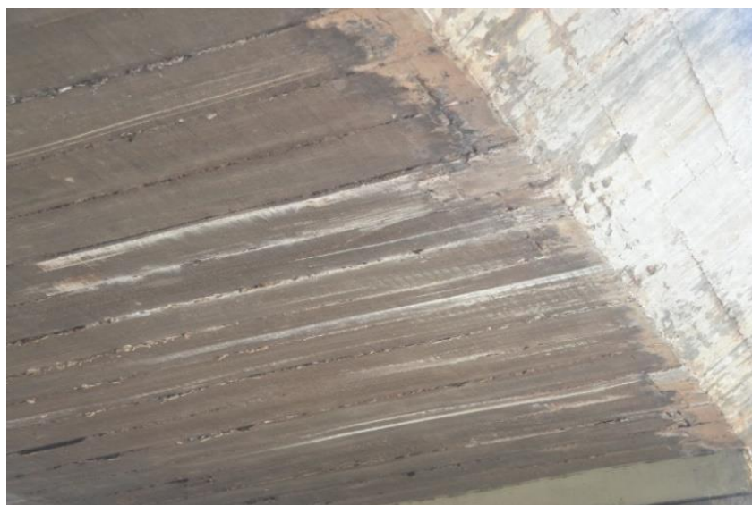
Figura 47: Exemplo B – abrasão do concreto com fator de intensidade 3
