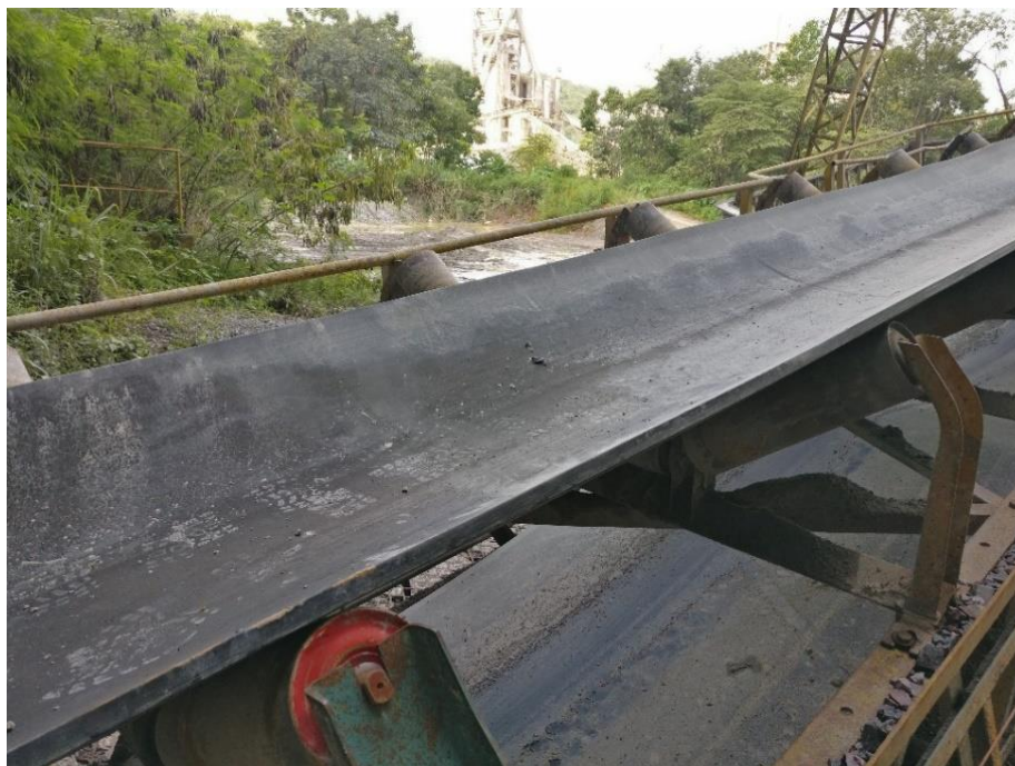
Figura 4.19 Instalação da correia de aramida (Arquivo Pessoal)
