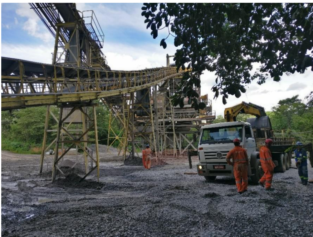
Figura 4.17 Instalação da correia de aramida (Arquivo Pessoal)
