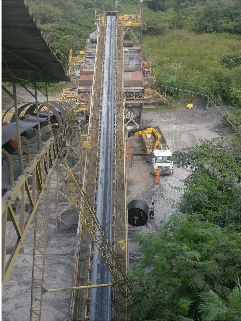
Figura 4.18 Instalação da correia de aramida (Arquivo Pessoal)
