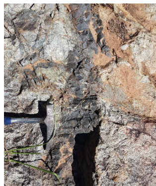
Figura 76 - Dique básico fraturado com direção NW.
