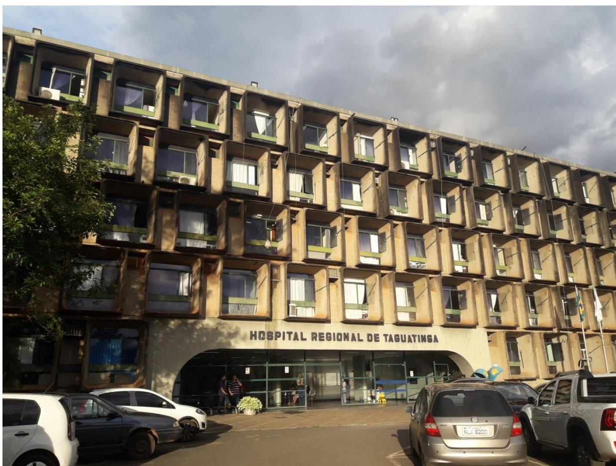
Figura 1 - Foto do Hospital Regional de Taguatinga
