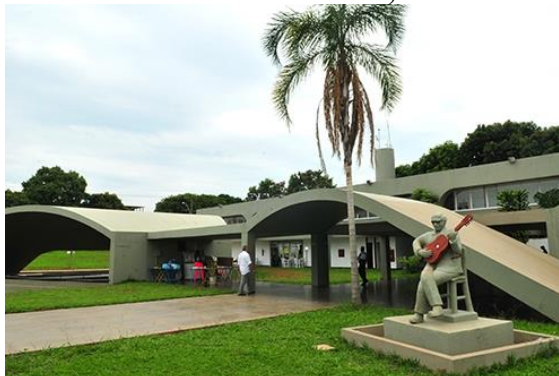
FIGURA 2: Casa do Cantador, Ceilândia DF
