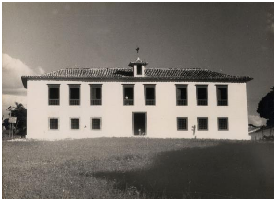
Figura 5 - Vista frontal do edifício após a reforma, 1951
