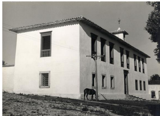
Figura 6 - Vista lateral do edifício após reforma, 1951
