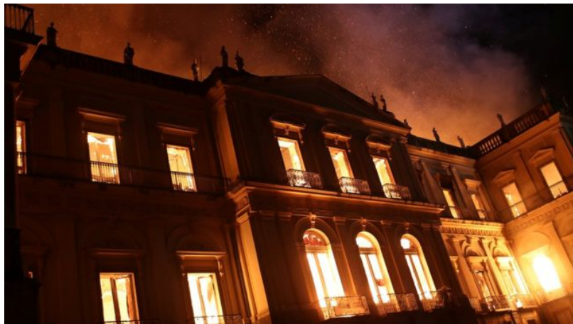
Figura 2.8: Fachada do Museu Nacional do Rio durante incêndio.[2]
