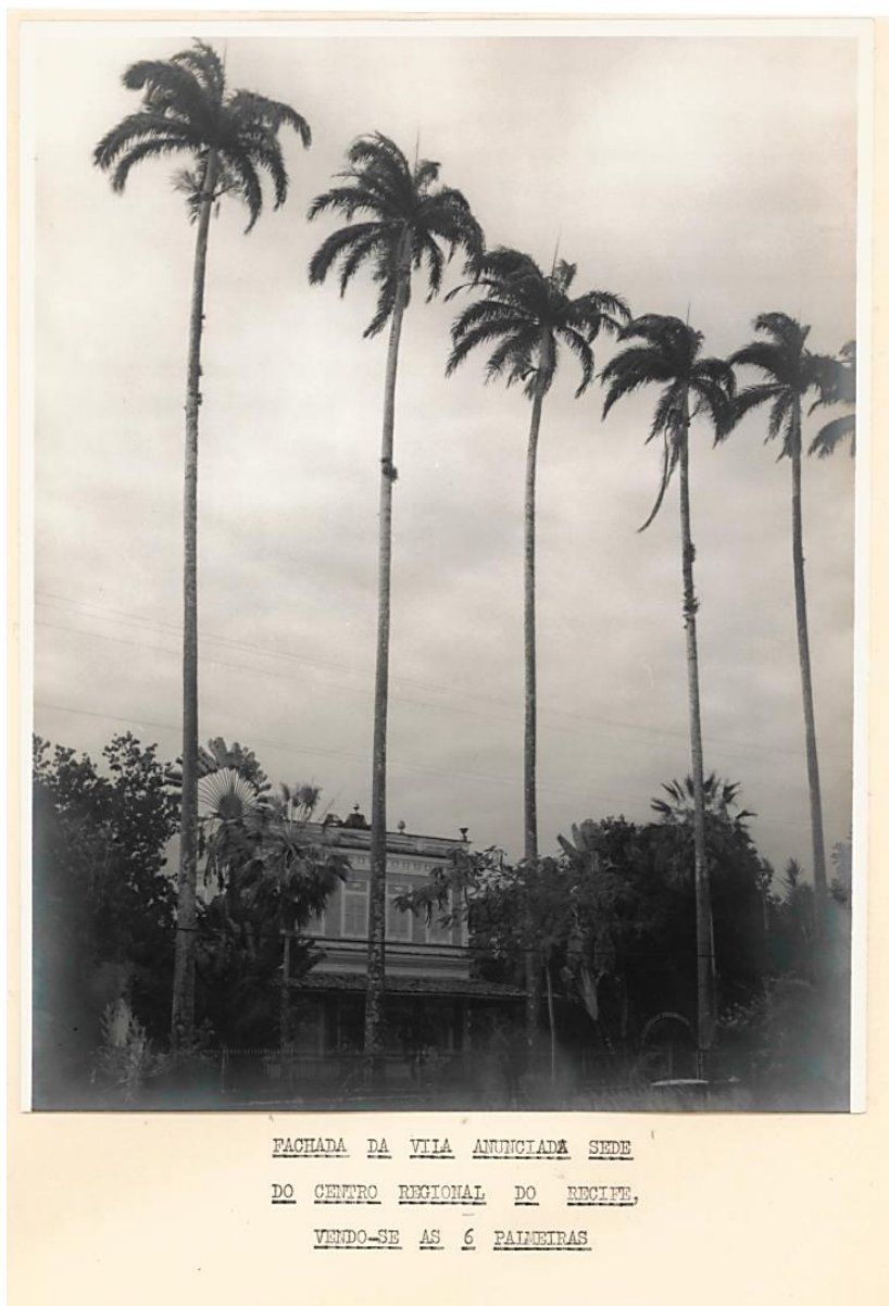
Fotografia 4: Fachada do CRPE/RE
