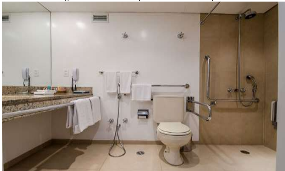
Figura 1 - Banheiro adaptado com barras de apoio
