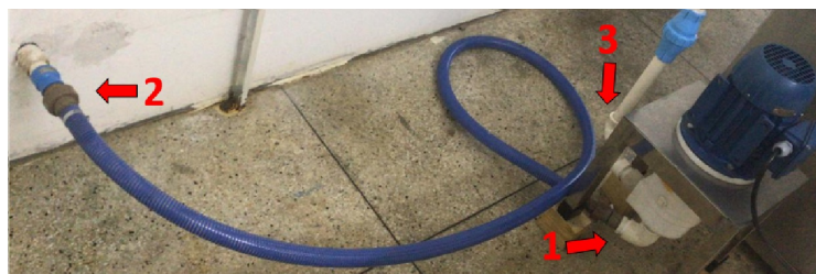
Figura 4.3: Tubulações que conectam os tanques de produção com a entrada da bomba pressurizadora.
