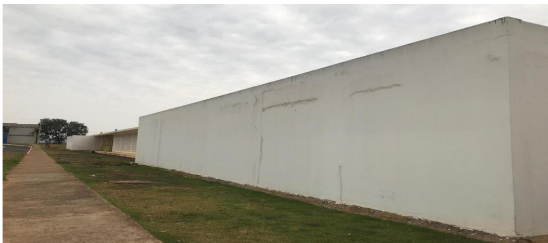
Figura 16 - Fachada oeste da FACE.
