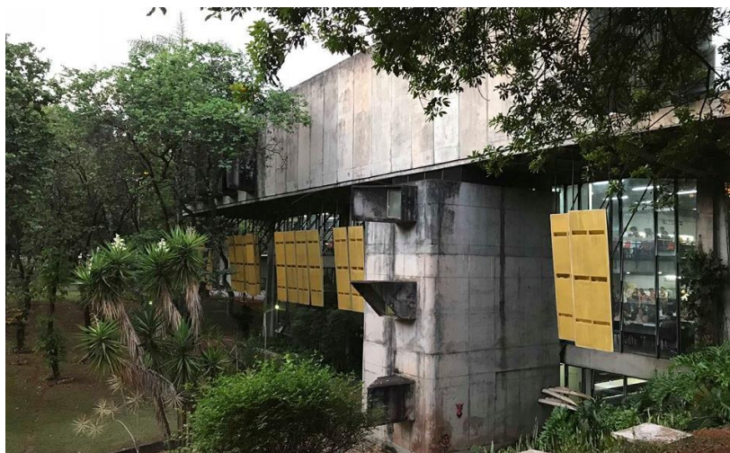
Figura 8 - Fachada Oeste R.U.
