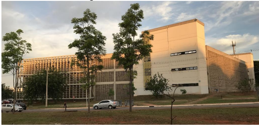
Figura 14 - Edifício BSA Sul.
