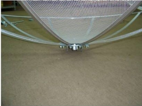
Colocação das Telas nas longarinas
