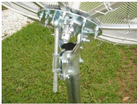
Fixação da Antena no Tubo
