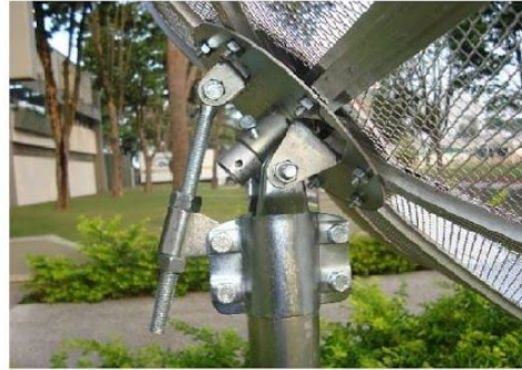
Fixação da Antena no Tubo
