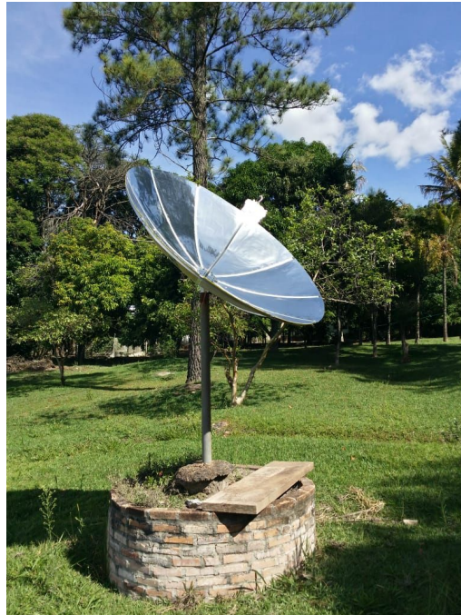
Figura 3.12 - Fixação da base de sustentação do concentrador, junto com todo o sistema, em um tubo de aço preso por concreto no chão.
