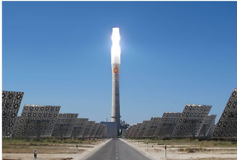
Figura 2.6 - Usina heliotérmica com torre central Gemasolar, Espanha (Burgaleta et al., 2011 apud INPE, 2017).
