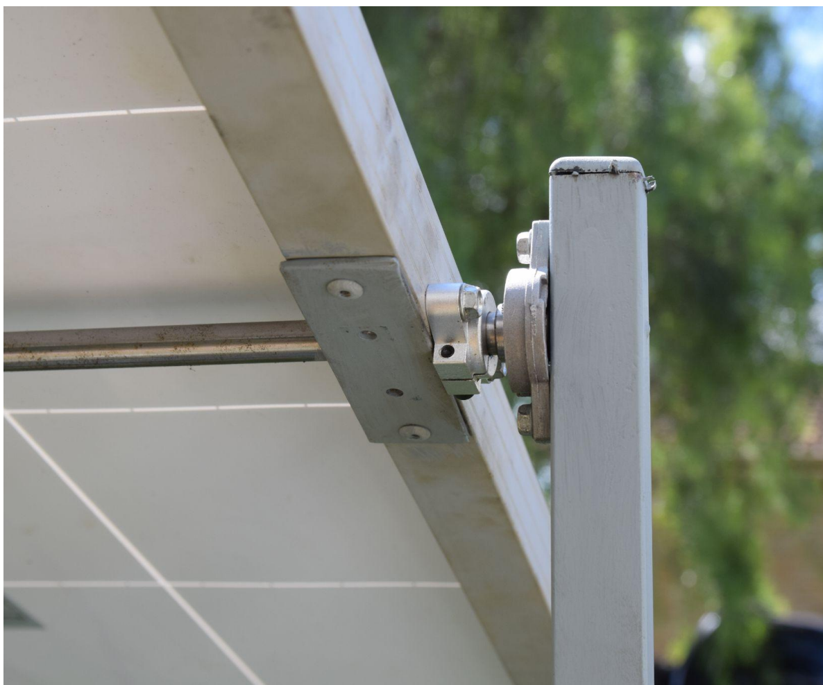
Figura 15. Foto do eixo horizontal, mancal e suporte.(Autoria própria).
