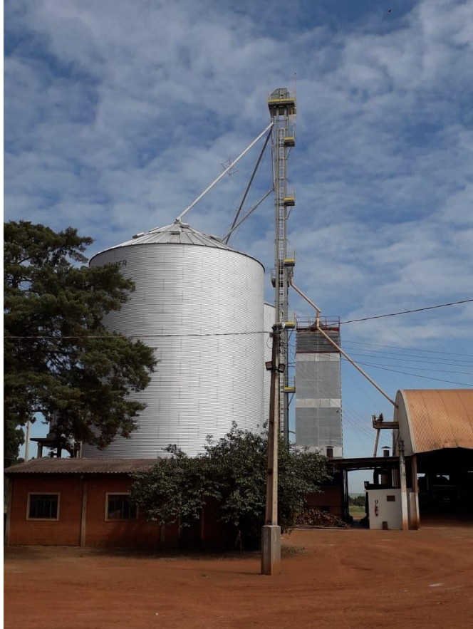
Anexo C – Silo metálico de um dos produtores entrevistados
