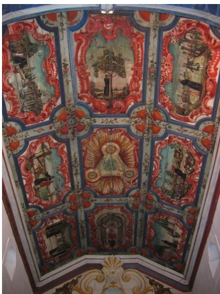
Figura 1 – Visão geral do forro da capela-mor
