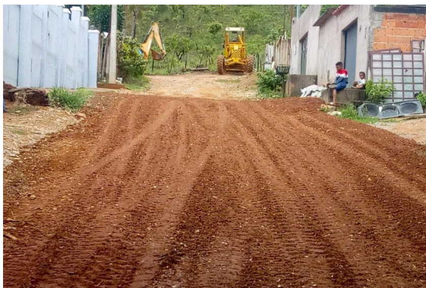
Figura 44: Utilização de ARC proveniente da URE/DF em vias sem pavimentação (Planaltina/DF)
