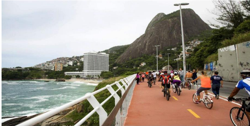
Figura 4 - Ciclovía de pavimento rígido. Fonte: Cimento Itambé (2016).
