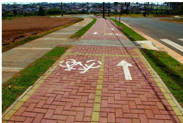
Figura 5 - Ciclovía de piso intertravado. Fonte: Bricka pisos intertravados (2019).
