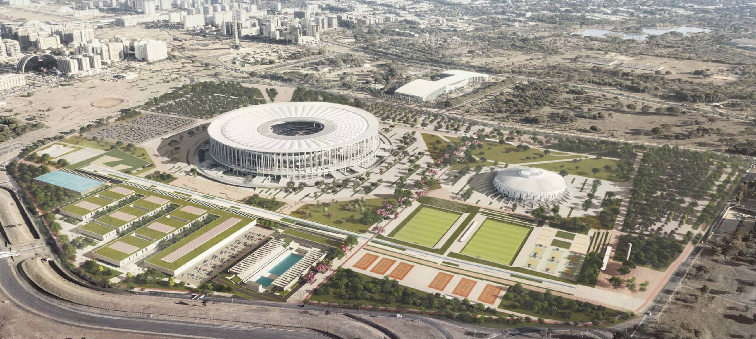
Figura 157. Disponível em: < https://arqbr.arq.br/projeto/arena-bsb/ >
