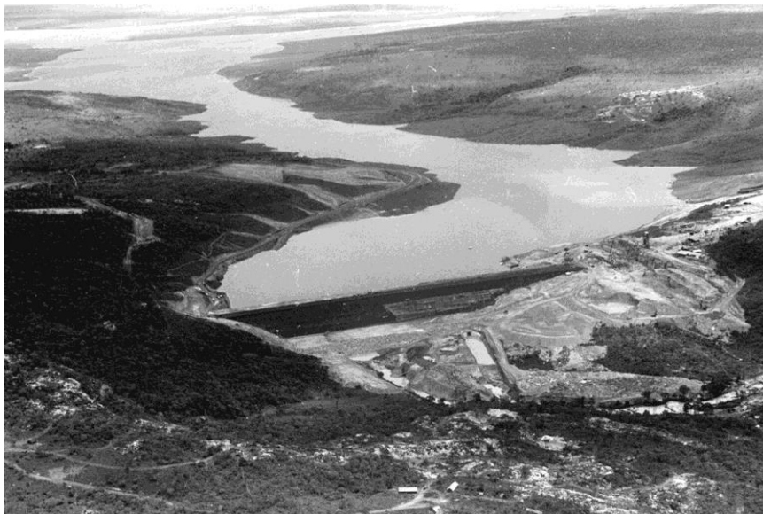
Fotografia 6 - Construção da Barragem do Paranoá
