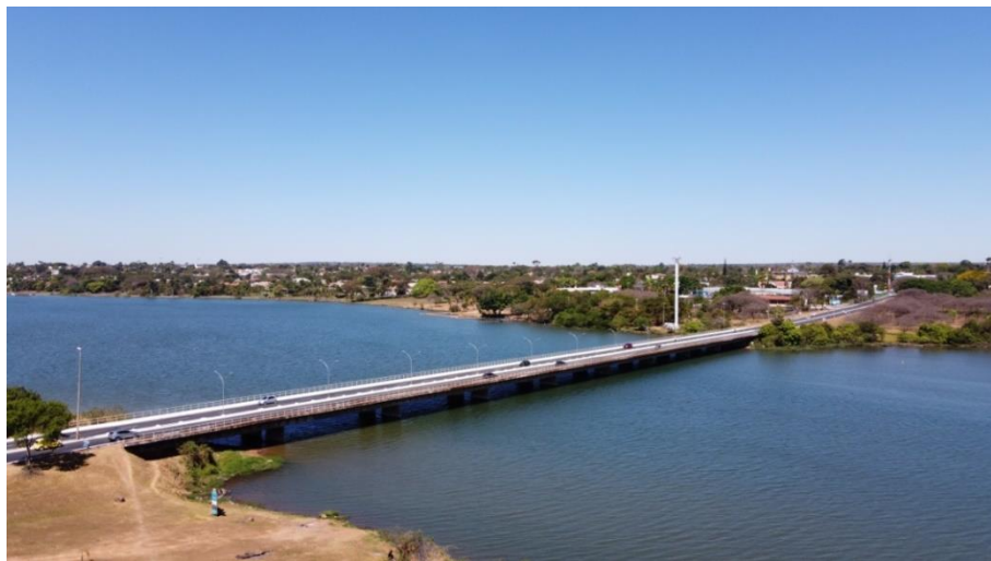
Fotografia 102 - Ponte das Garças
