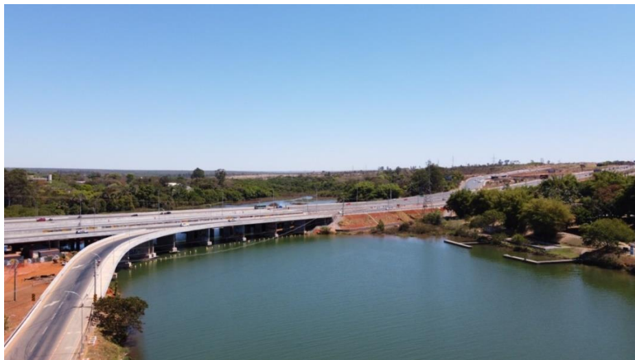
Fotografia 101 - Ponte do Bragueto
