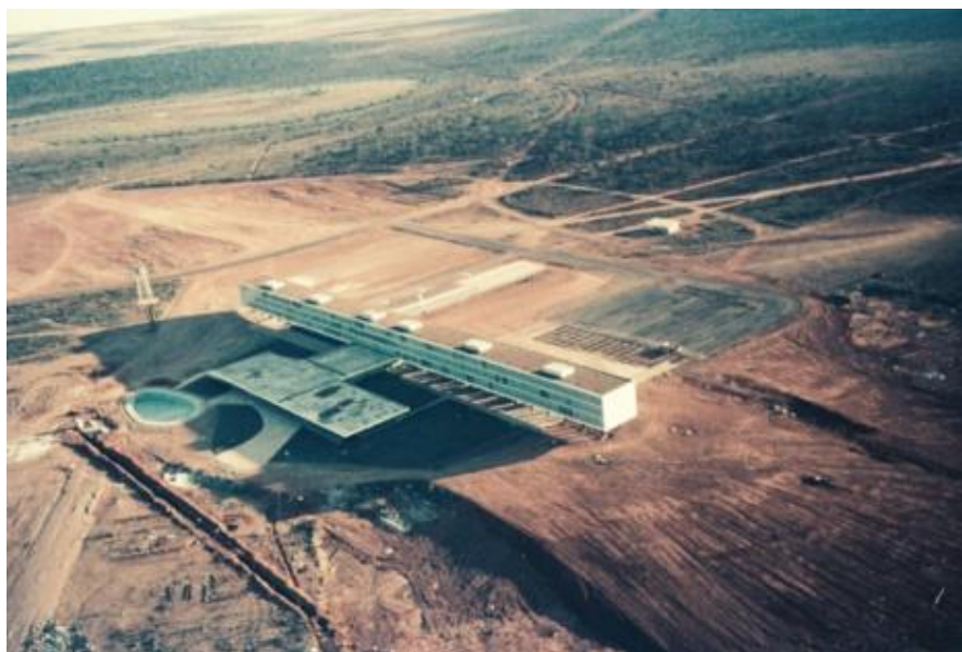
Fotografia 47 - Brasília Palace antes de existir o lago
