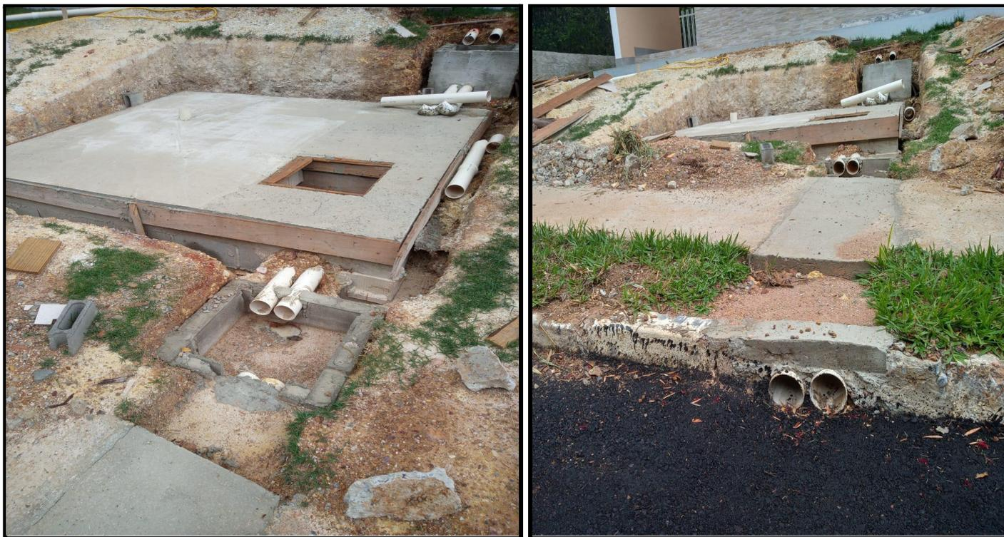
Figura 51 e 52: Área de captação e liberação de águas das calhas - Condomínio Santa Mônica. 2021.
