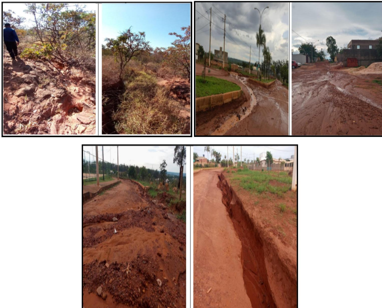
Figura 12, 13 e 14: Imagens do processo erosivo e do escoamento das Quadras 5, 4 e 1 antes das obras. Fonte: Laudo Técnico, 2020
