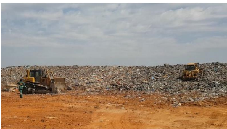
Figura 3-9: Processo de compactação do lixo no Aterro – Aterro Sanitário de Brasília
