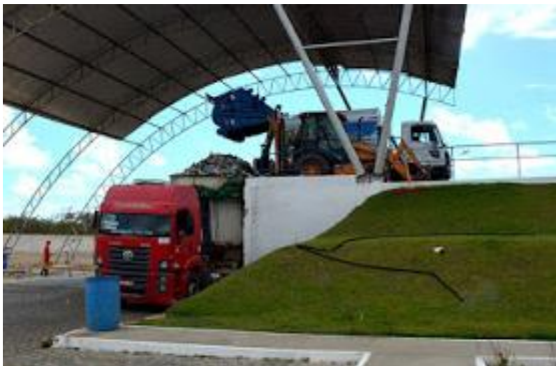
Figura 3-5: Estação de transbordo de Parnamirim
