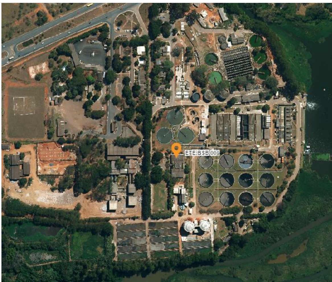
Figura 3.8 – Visão aérea da Estação de Tratamento de Esgoto Brasília Sul (Fonte: CAESB, 2020).
