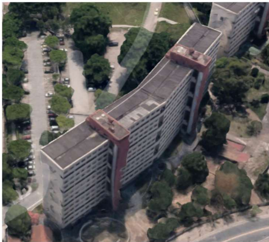
Figura 1.1 - Imagem aérea da edificação
