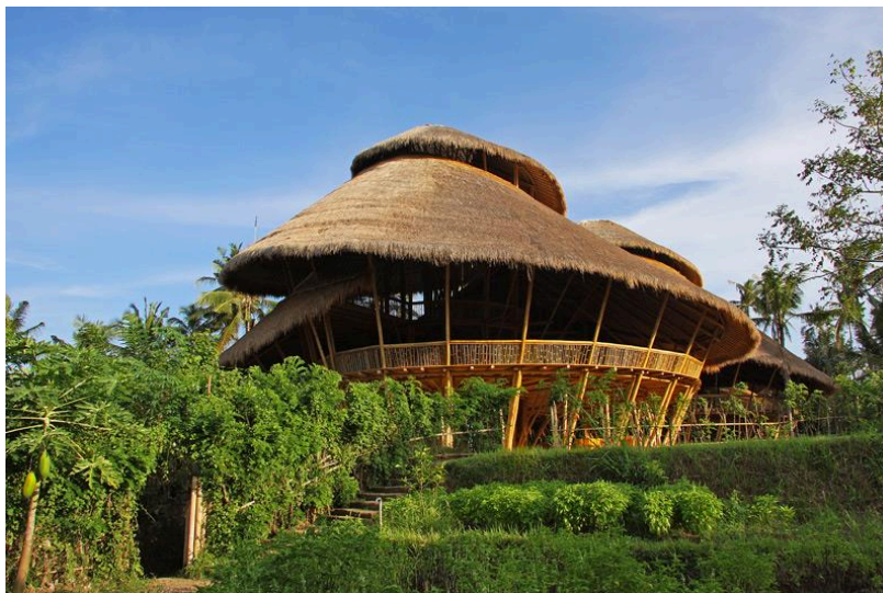
Foto 4: Green School, bioconstrução com bambu e palha Fonte: fotografada por Henrique Veloso
