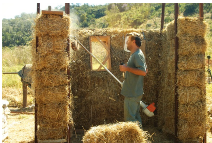
Foto 3: Bioconstrução com fardos de palha
