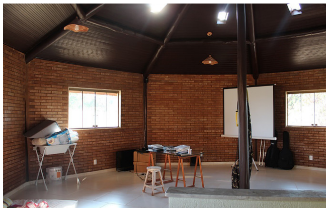
Foto 5: Iluminação natural com telha de vidro
