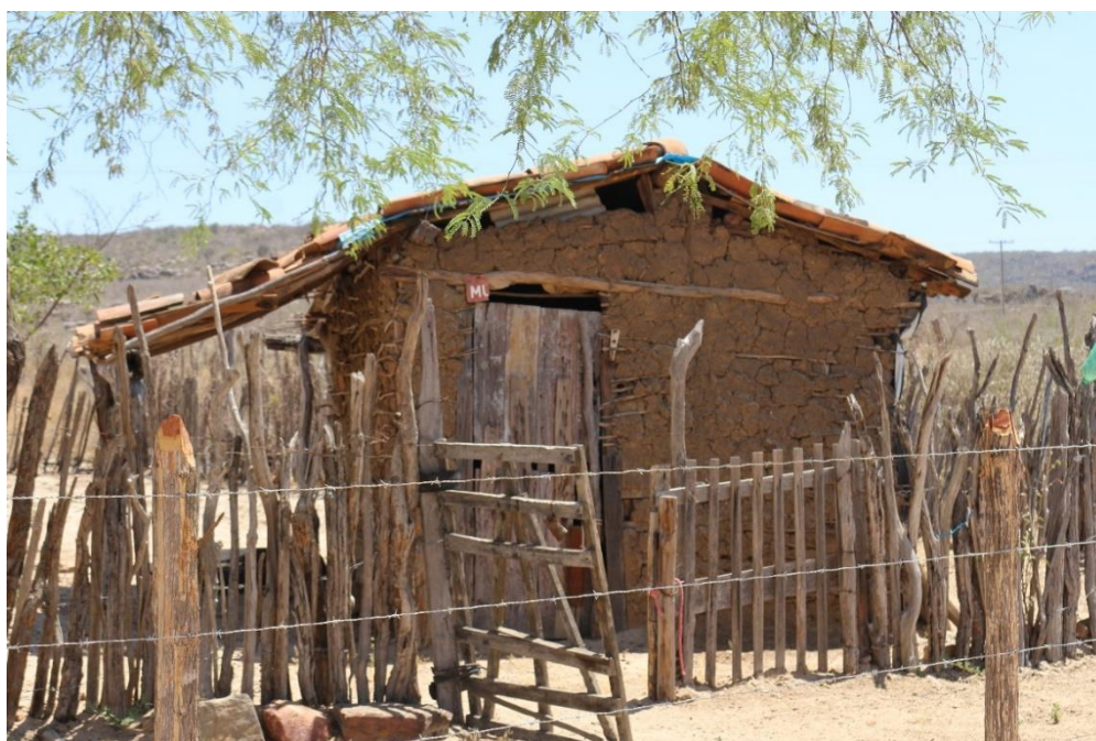
Figura 13 - Casa fora dos padrões necessários, com telhado pequeno e sem estrutura para inserção do sistema de captação. Fonte: Autora
