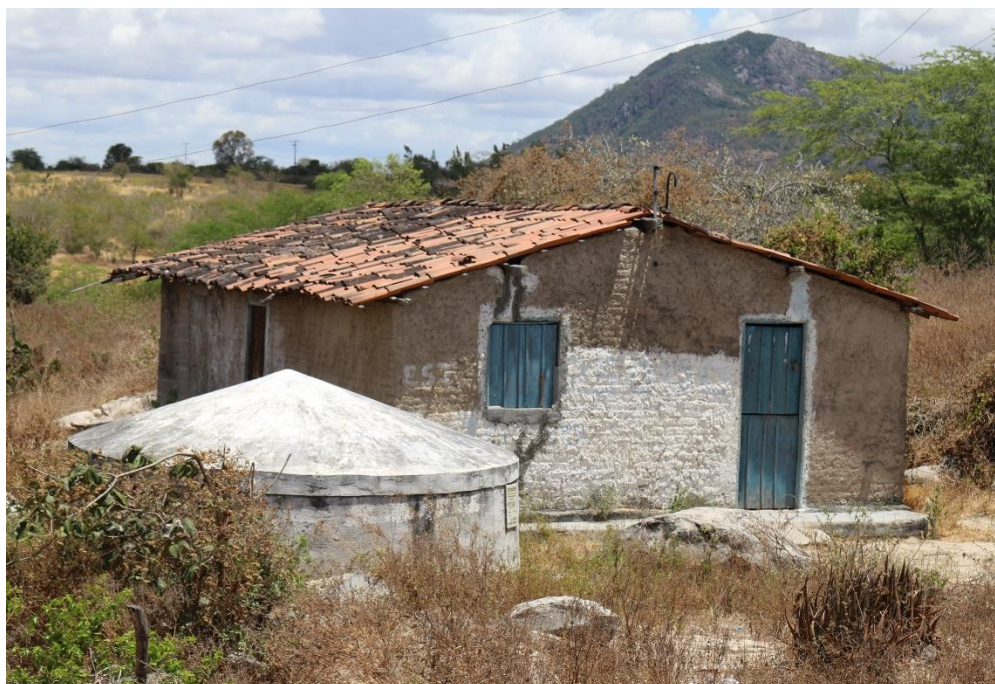
Figura 14 - Casa com cisterna, mas sem estrutura de captação como calhas e tubulações. Fonte: Autora
