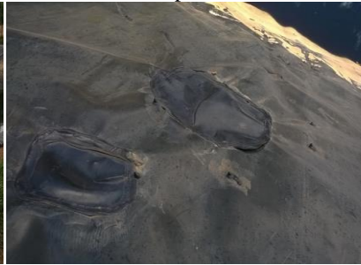
Fotografia 8 - Reparos feitos na manta impermeável
