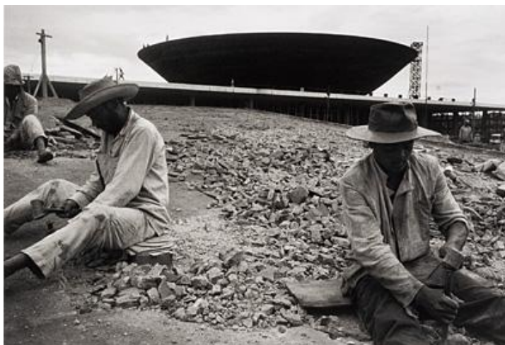
Figura 1- Operários na construção, 1959, autor não identificado (Arquivo Público do Distrito Federal)
